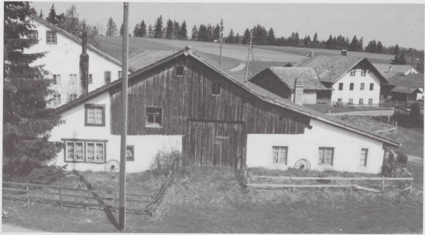
Lajoux : maison mitoyenne avec ses deux «tieurtis».
