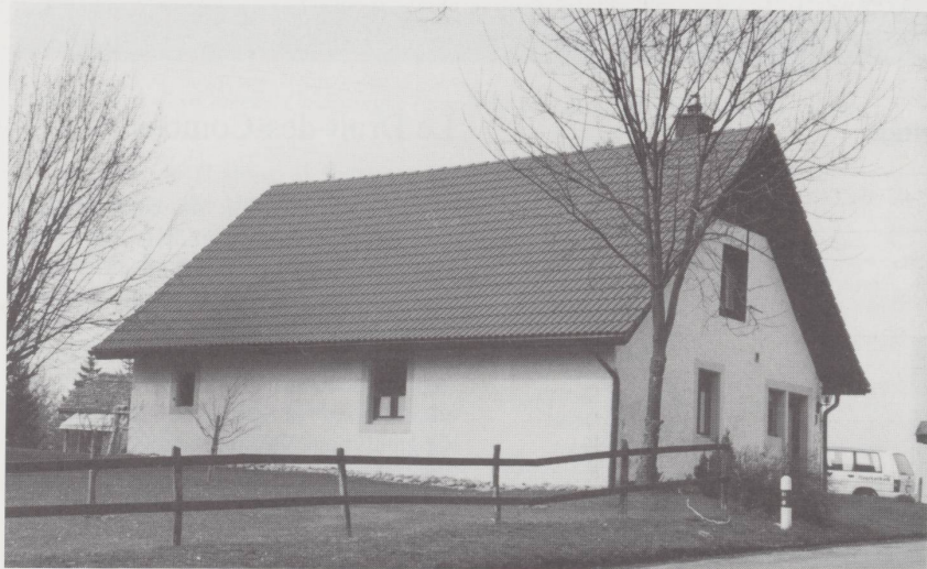
Loge du Cras-des-Mottes. A cheval sur la crête, la chambre était djoulaise et la cuisine saulcy.
