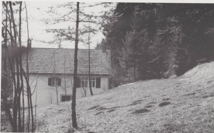
Loge du Droit-des-Combes. On distingue l'accès du pont de grange sur le replat à droite.
