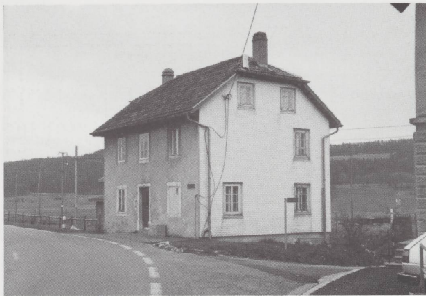
Le Noirmont, sortie du village côté est. Le garde-bétail utilisait le rez-de-chaussée.
