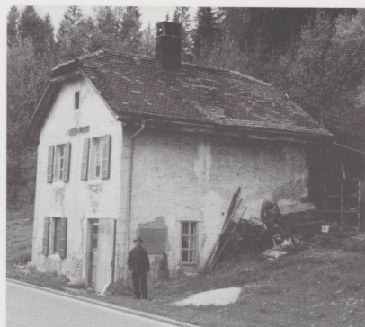
Loge du Grand-Creux, construite à un pas de la route.
