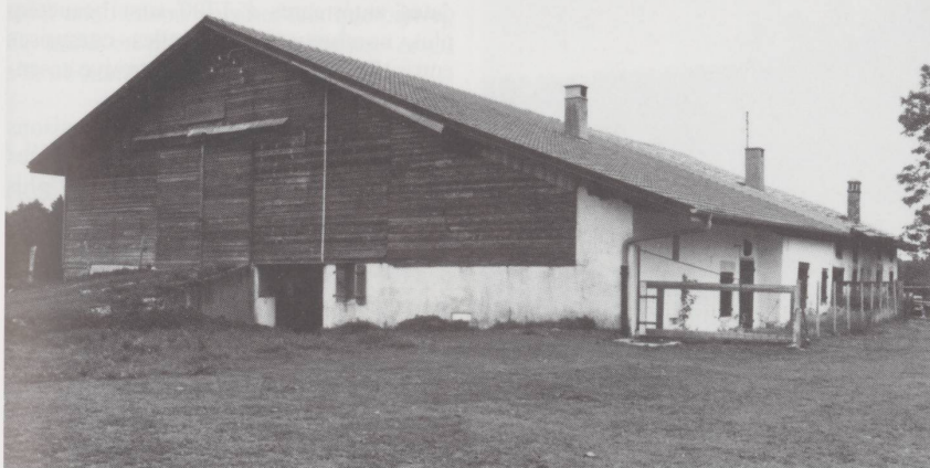
Appelées « mal tournées » dans le Jura neuchâtelois, une minorité de bâtiments ont le faîte du toit orienté dans le sens des vents dominants. Cette disposition permet, comme ici au Peuchapatte, d'accoler à bon compte deux ou trois maisons toutes exposées au soleil de la matinée.
