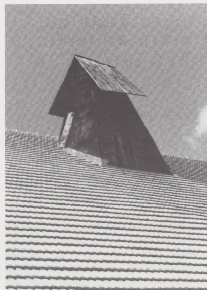
Le tronc de pyramide du «tué» de bois traverse le toit; son orifice est protégé des vents et des précipitations par un ou deux volets (Le Cerneux-Péquignot, NE). La pente n'excédant pas 30°, le risque de glissement est réduit, tant pour les bardeaux non cloués que pour les couvreurs.
