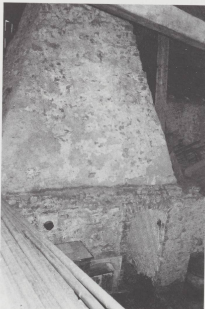
Les Entre-deux-Monts (La Sagne, NE). Cette vaste hotte de cheminée en pierre, appelée ailleurs «tué», coiffe toute la cuisine; elle mesure 3,2 mètres sur 2,5 mètres à la base. Au premier plan, l'ancienne chambre chauffée, ou «poêle».
