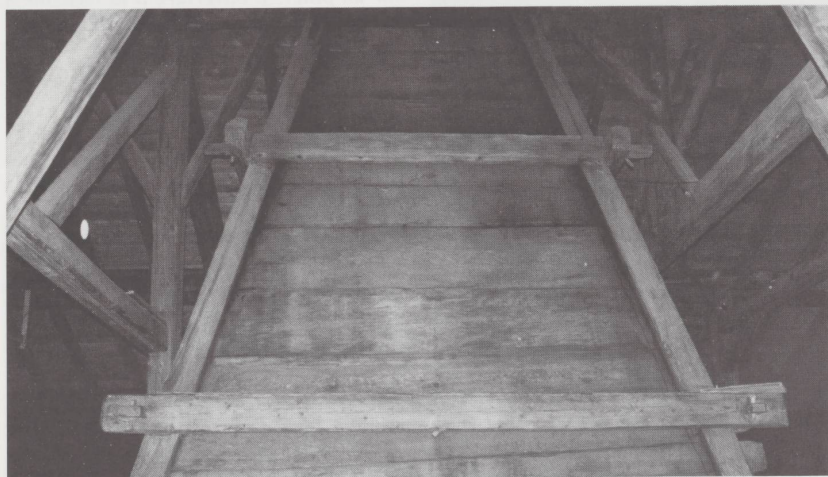
Cheminée de bois, ou «tué», au Cachot (La Chaux-du-Milieu, NE). Les madriers de la hotte, posés horizontalement, s'encastrent dans les rainures de quatre montants obliques, eux-mêmes maintenus par deux cadres horizontaux.
