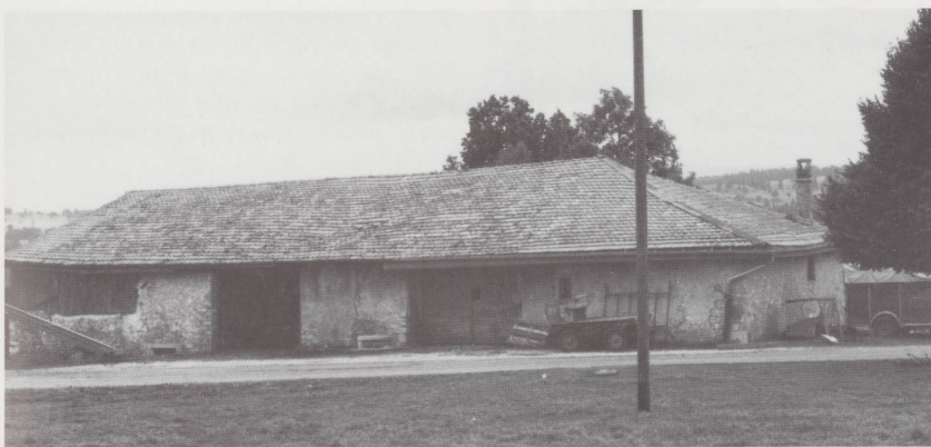
Au Peuchapatte, cette maison double (il y a deux entrées de grange) au toit peu incliné (environ 20°) doit dater du XVI e siècle. Elle a perdu sa croupe du côté bise (à gauche) à la suite d'un incendie; le toit n'a donc plus que trois pans. Il s'agit presque d'une «mal tournée», au sens neuchâtelois du terme, puisque le faîte est orienté sud-ouest/nord-est.
