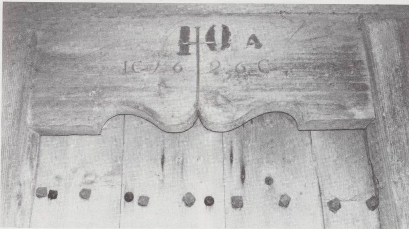
Le Peuchapatte. Porte de grenier séparé chevillée dont le linteau porte la date de 1696.
