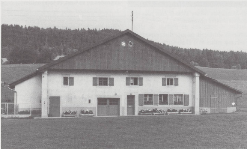
Le rez-de-chaussée de la majorité des anciennes fermes du Haut-Jura neuchâtelois se partageait sous le faîte en deux moitiés: l'une consacrée au «rural» (étable et remise), et l'autre affectée au logement. Dans cette maison des Cœudres (La Sagne, NE), les deux adjonctions et la grande porte sont assez récentes.
