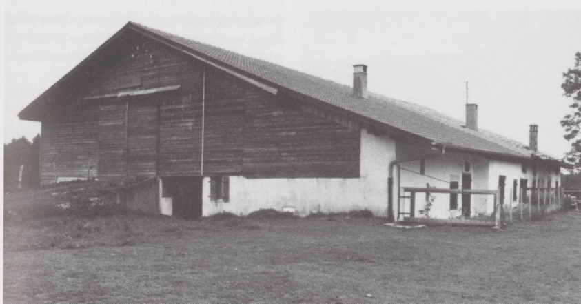
Appelées « mal tournées » dans le Jura neuchâtelois, une minorité de bâtiments ont le faîte du toit orienté dans le sens des vents dominants. Cette disposition permet, comme ici au Peuchapatte, d'accoler à bon compte deux ou trois maisons toutes exposées au soleil de la matinée.
