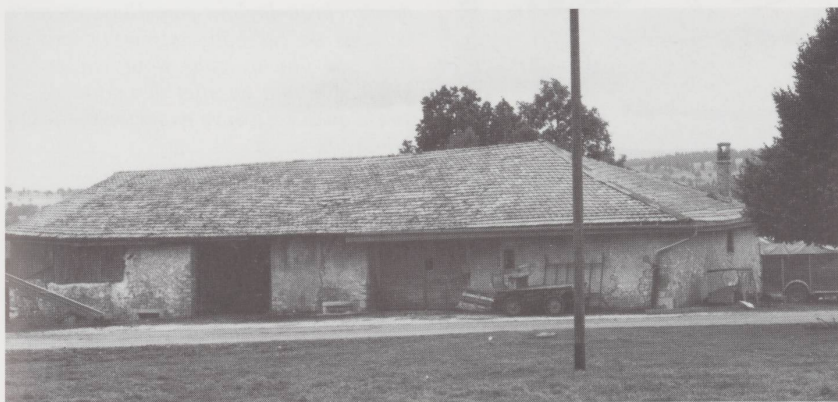
Au Peuchapatte, cette maison double (il y a deux entrées de grange) au toit peu incliné (environ 20°) doit dater du XVI e siècle. Elle a perdu sa croupe du côté bise (à gauche) à la suite d'un incendie; le toit n'a donc plus que trois pans. Il s'agit presque d'une «mal tournée», au sens neuchâtelois du terme, puisque le faite est orienté sud-ouest/nord-est.
