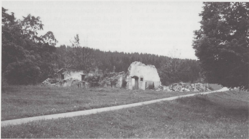
Montagne de l'Envers, Courtelary. Ferme de la Thellung, avant et après incendie. (Plainte a été déposée.)
