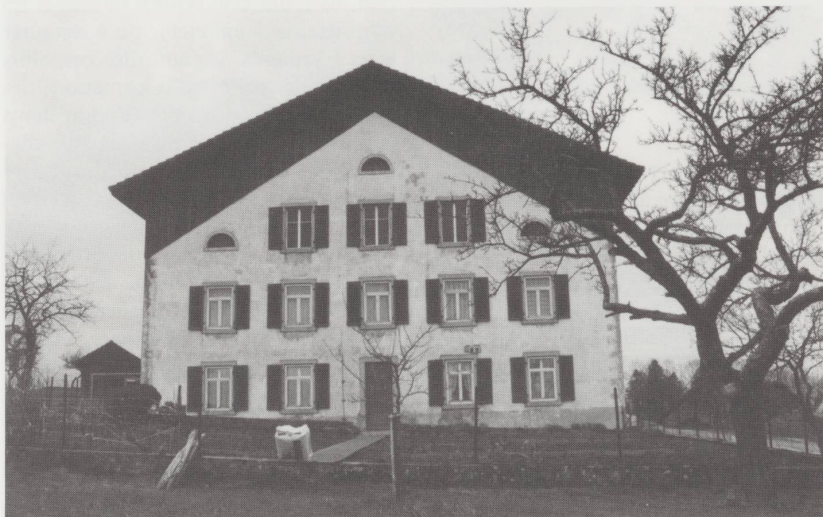
Epiquerez. Ferme « Le Chat ». Surélévation de 2 mètres. Le résultat d'un petit permis ! A vous de juger. L'ASPRUJ n'a pas connaissance des petits permis ; elle ne peut donc pas intervenir.
