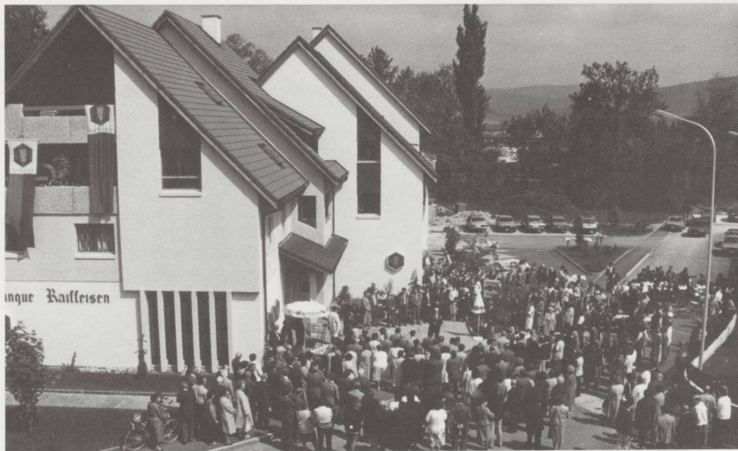
Courrendlin. Jour d'inauguration. Dans cet important village déjà urbanisé, la Banque Raiffeisen a choisi pour son siège, un petit immeuble locatif en bordure du centre historique.
