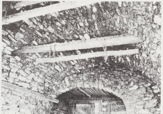
Le plafond de la cuisine du Bois-Rebetez, Franches-Montagnes.
