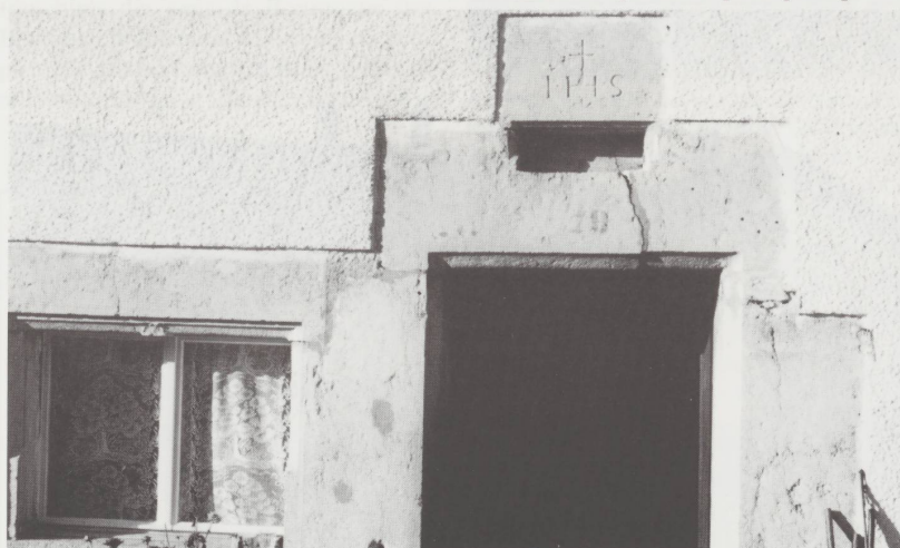
Les Peux. Le linteau s'est brisé en raison de la surcharge due à un manque d'attention lors de l'abattage de la voûte de la cuisine. Le meneau de la fenêtre manque. Malgré un bouchardage soigné, des traces de suie subsistent dans « l'évent ».
