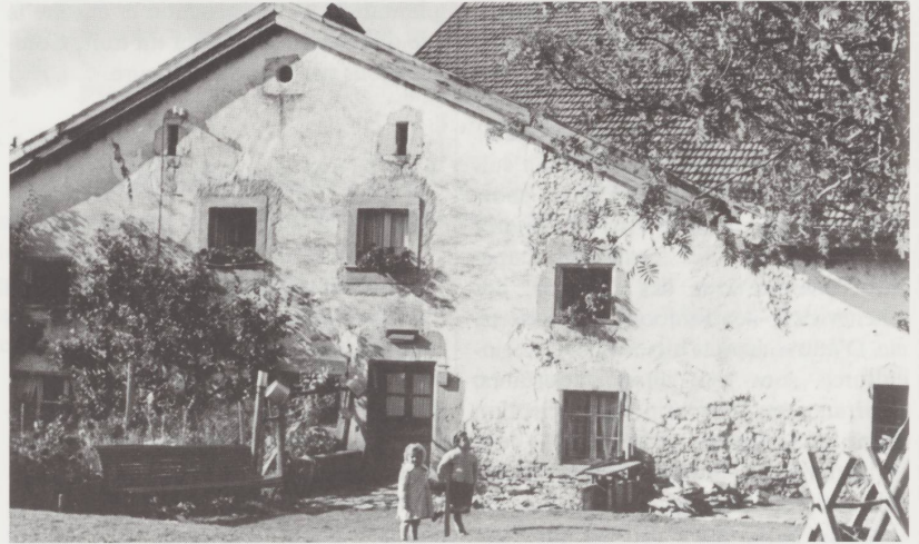
La ferme paternelle au Peux des Emibois a conservé intact l'œil de bœuf daté P 1684 C. Le pâturage touche la porte de la cuisine. Les deux fenêtres jumelles sont récentes. Les autres ont perdu leur meneau, la fenêtre de la cuisine haute — derrière le chevalet — n'a pas les mêmes caractéristiques; oblongue et d'un calcaire blanc. Le toit visible a été agrandi en 1931. Vue plein sud. Son aspect primitif, côté est, par analogie montré à la photo suivante.
