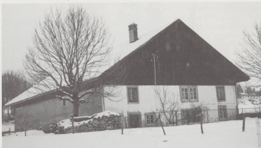
On a refait la couverture du bâtiment en conservant au pignon sud-est l'avant-toit en berceau à contre-courbes. (Photo Marie-Thérèse Fleury)
