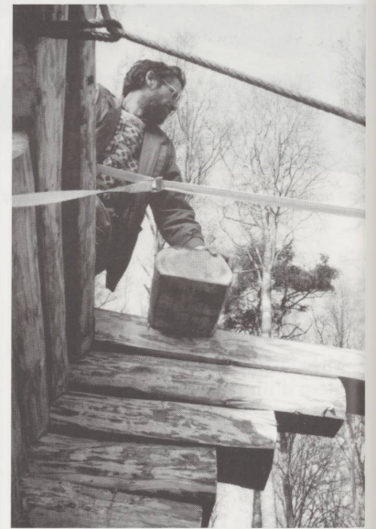
La mise d'équerre de la structure du refuge forestier, lors de sa construction. A la direction de la manœuvre : Michel Godinat. Photo parue dans le N° 31, mars 1992.
