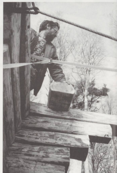
La mise d'équerre de la structure du refuge forestier, lors de sa construction. A la direction de la manœuvre : Michel Godinat. Photo parue dans le N° 31, mars 1992.
