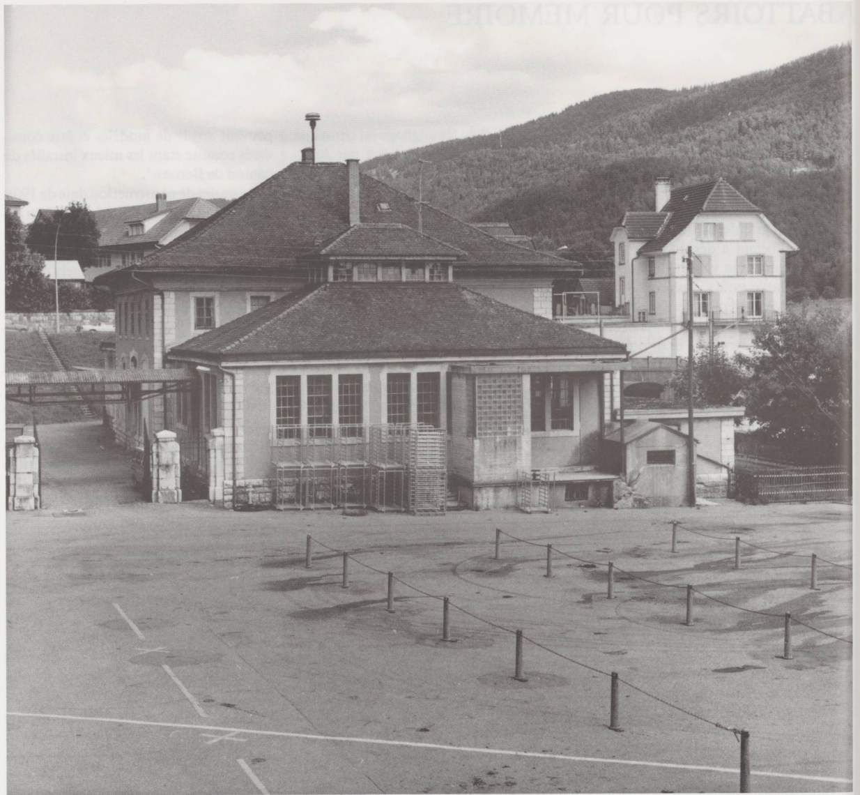
Abattoirs de Saint-Imier. Vue du bâtiment depuis la place des abattoirs (ouest).
