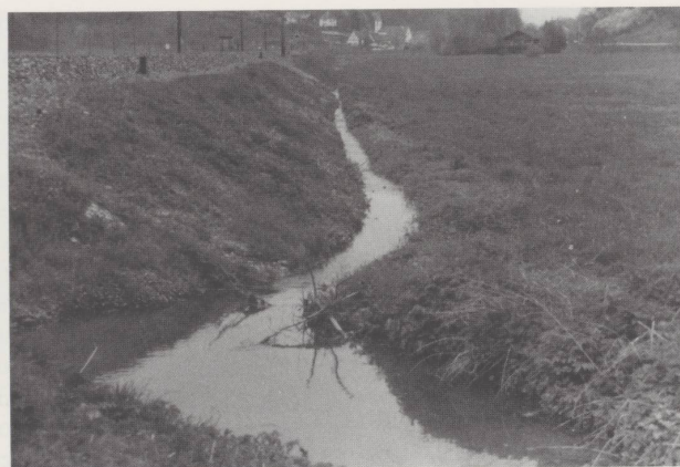
Malgré ses dix aqueducs, le remblai est un obstacle. Un nouveau canal s'est formé le long de la ligne des CFF.
