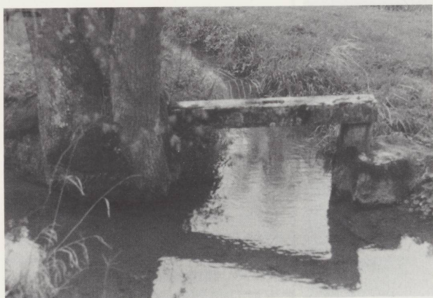
Point de séparation du canal secondaire (le terra) du gros canal (aux prés des Messes).
