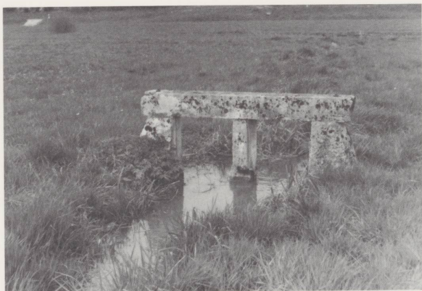
Une belle petite écluse particulière (il manque les vannes).
