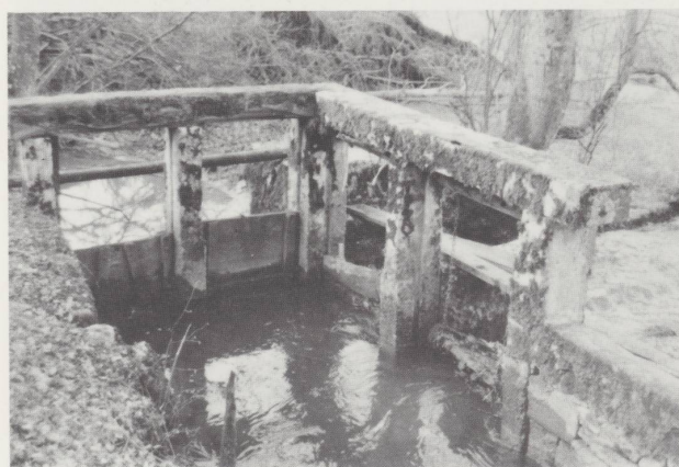
Ecluses: du canal d'amenée à gauche, du canal de décharge à droite.
