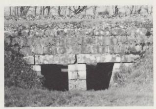
Un des dix acqueducs traversant le remblai de la ligne des chemins de fer (... le béton n'existait pas encore lors de la construction!)
