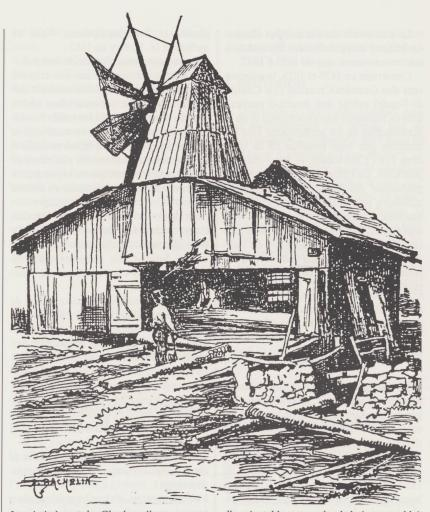
La scierie à vent des Charbonnières, avec sa tourelle orientable et ses pales de bois, ressemblait peut-être aux petites usines éoliennes de La Chaux-du-Milieu et du Cerneux-Péquignot.
