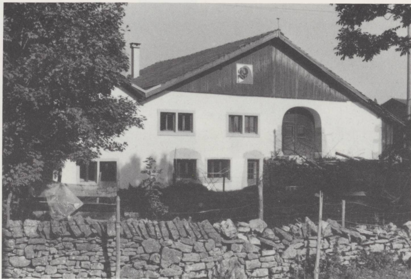
La ferme du centre du hameau est entourée par le pâturage ; son courtil est donc protégé d'un mur de pierres typique bien conservé. (6)
