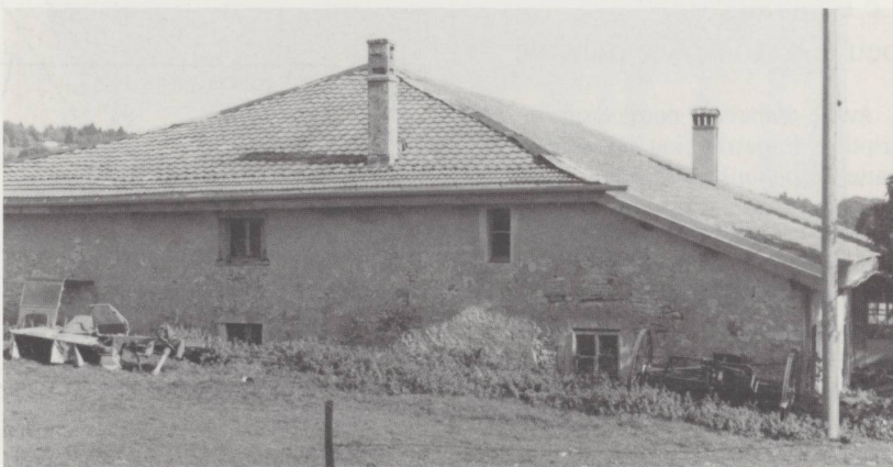
Les fenêtres à ras du sol révèlent le niveau inférieur de la ferme un peu enfoncé dans le terrain. On descend souvent une ou deux marches en entrant dans une ferme du Haut-Jura! (2)
