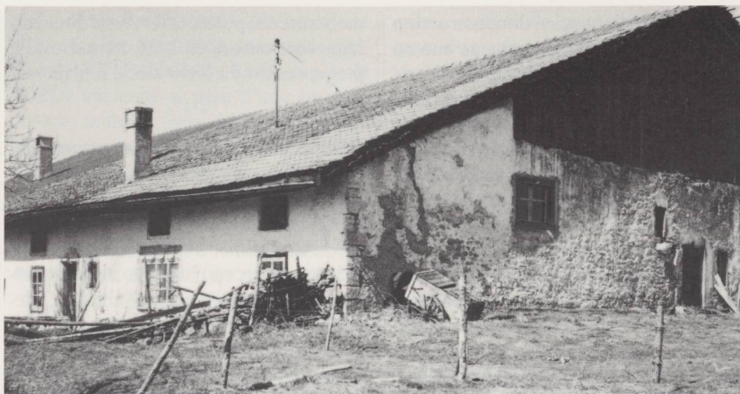
Sur la façade orientale de cette ferme se voit encore une porte d'écurie de la fin du XVI e siècle, avec linteau à arc infléchi. La façade principale, au sud, est un mur gouttereau; remarquer les fenêtres des chambres à coucher sous l'avant-toit. (3)
