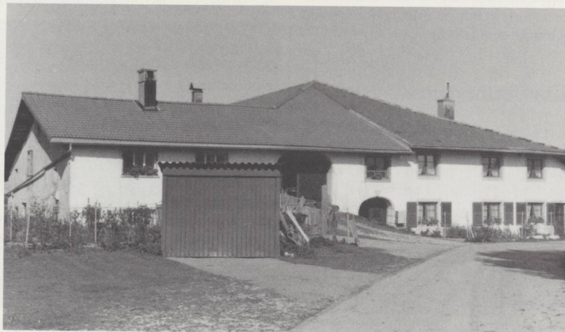
Belle ferme à toit à quatre pans du XVII e prolongée en « mal tournée » au XIX e siècle déjà. (5)
