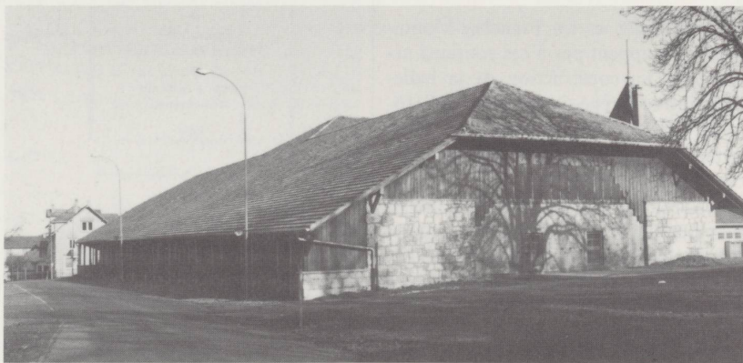
La halle aux chevaux vue du nord-ouest avec son imposant toit à demi-croupe et ses soubassements en pierre de taille.
