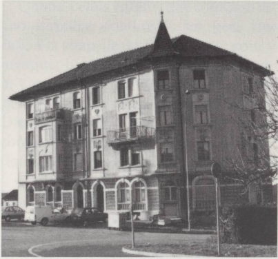
L'ancien Hôtel du Spiegelberg, aujourd'hui bâtiment comprenant six logements. La présence d'un oriel — fenêtre en encorbellement faisant saillie sur un étage — et d'une tourelle d'angle — donne à ce bâtiment de 1904 un air citadin.
