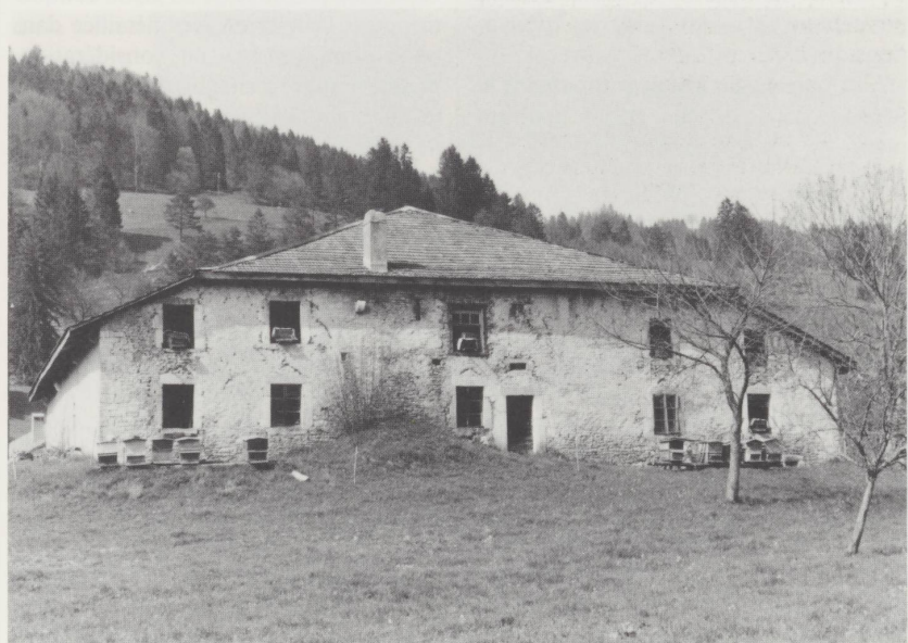
Soubey, Chercenay. Ferme abritée sous un toit à quatre pans, probablement du XVII e siècle, caractérisée par son harmonieuse volumétrie d'origine.
