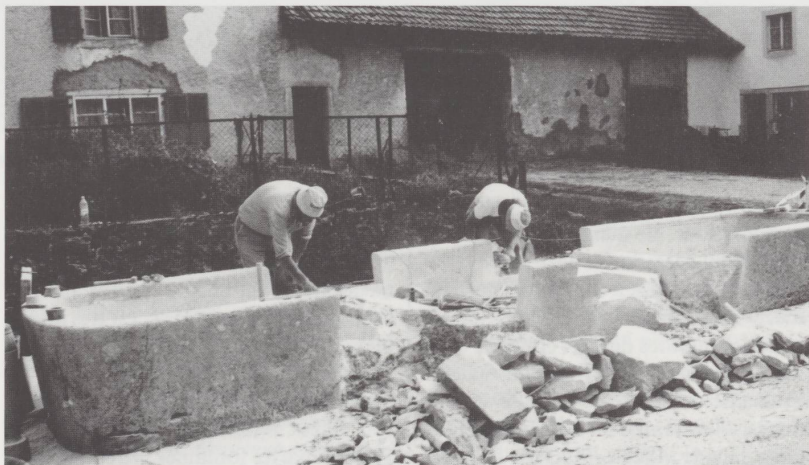
Travaux de réfection de l'une des fontaines du village, en été 1991. Les ouvriers procèdent au remplacement des parties en béton, par de la pierre.
