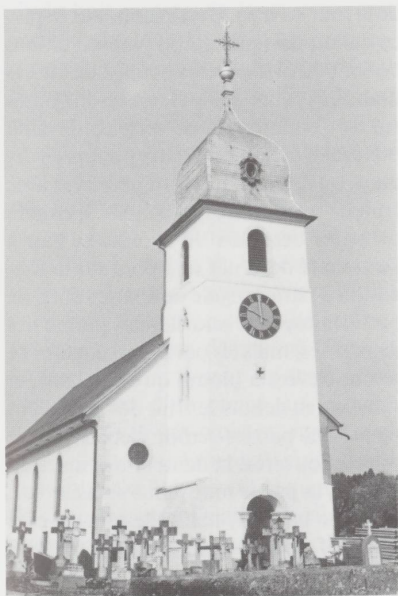
Les façades extérieures de l'église ont été recrépies à la chaux, selon la composition du matériau d'époque. On aperçoit sur le côté latéral gauche de la tour deux fenêtres romanes et plus haut une troisième de style gothique. Ces éléments ont été empruntés à l'église primitive.
