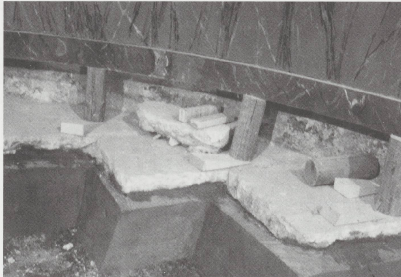
Le sol actuel du chœur était situé à quelque trente centimètres au-dessus du sol primitif. Il a donc retrouvé sa situation originale. Notre photo montre les pierres calcaires du sol de 1788.
