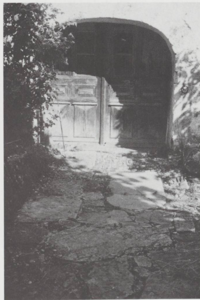
Maison N° 7. Le pavage devant la porte du « chari » a été remanié il y a fort longtemps déjà: les pavages faits de petites pierres non taillées, comme ici juste devant la porte, résistaient bien au passage des chevaux et des chars qui ne glissaient pas. Ils ont presque tous été supprimés ou remplacés par des pavages de remploi, comme ici où l'on reconnaît deux beaux montants de clédar.
