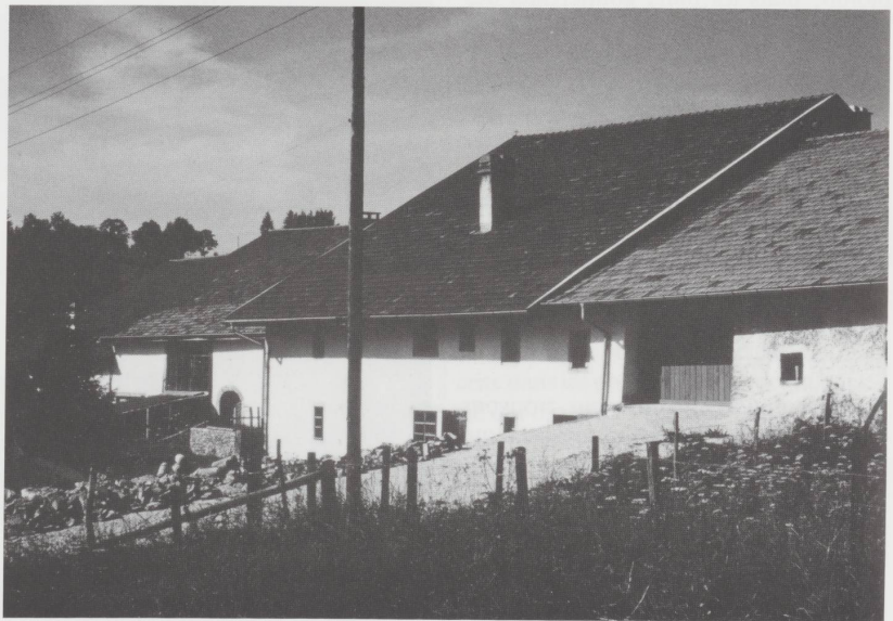
Les deux maisons mitoyennes (5 et 6) curieusement partagées par un mur commun parallèle aux façades-pignons nord et sud.
