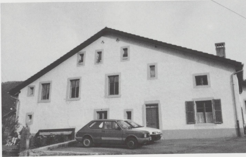
Rénovation respectueuse du volume ancien à Villeret. On n'a pas cherché non plus à donner aux douze fenêtres de cette façade un format identique ni un alignement. (Photo Odile Aubry.)
