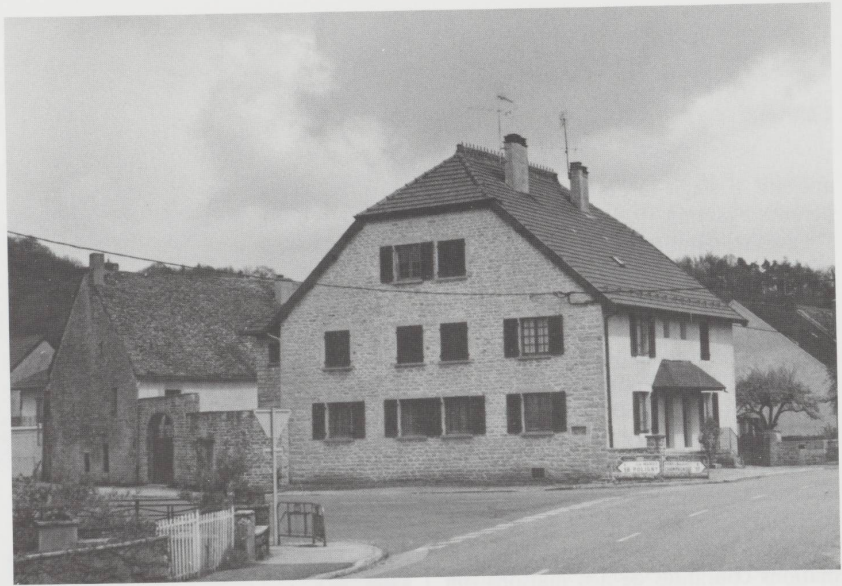
Ancienne maison rurale rénovée à Mirebel (Jura, France). Lors de la réfection complète de cette toiture (précédemment en « laves »), le couvreur a respecté l'absence d'avant-toit, ce qui donne beaucoup d'éclairage aux fenêtres haut placées. (Photo Marcellin Babey.)
