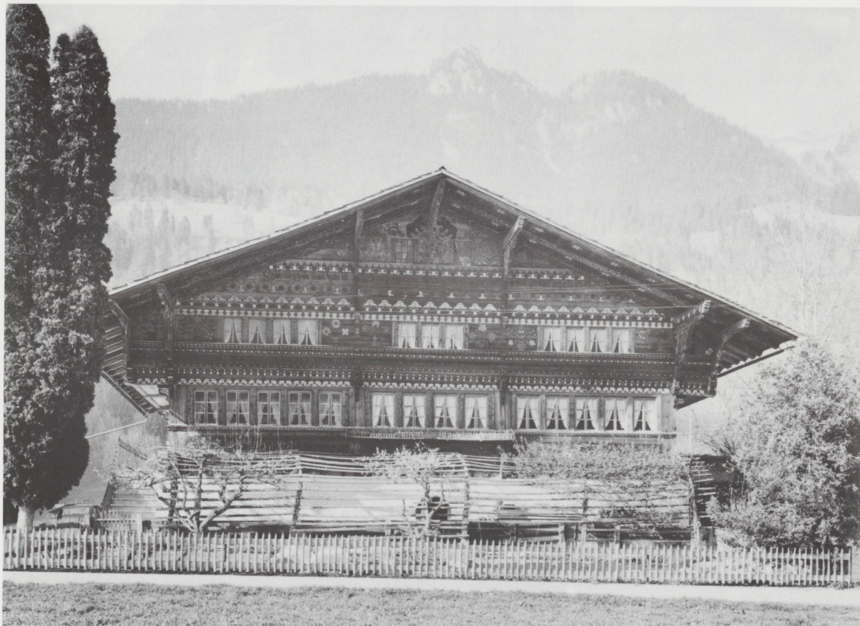
Maison Knutti à Moos (Därstetten), Simmental, canton de Berne. Cette superbe construction de 1756 montre l'importance extrême des avant-toits dans l'architecture bernoise. On n'a pas ici de balcon en pignon, mais latéralement de part et d'autre. Les pans du toit débordent même encore largement de ces balcons. On n'a ici que deux chevrons volants, mais fort espacés pour ne pas nuire à la décoration peinte sous le lambris de l'avant-toit. (Photo Hans Keusen, Ostermundigen.)
