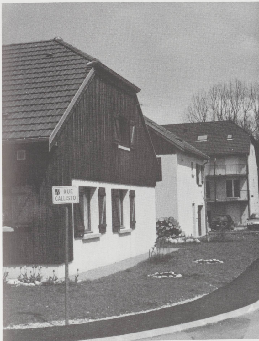
Résidences d'un lotissement neuf à Doubs (Franche-Comté). La tradition architecturale a été serrée de près ici, malgré le gabarit beaucoup plus petit de ces villas à un ou plusieurs logements. (Photo Marcellin Babey.)
