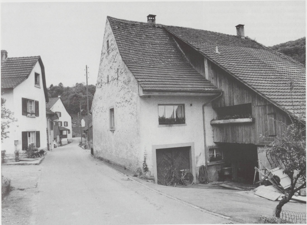
Rue du village à Wintersingen. Pignons francs. Le pignon du premier plan, ainsi que celui du Meierhof (photo précédente), ont pourtant conservé leurs enduits d'époque jusqu'au faite du toit. Ces enduits à la chaux reblanchis périodiquement, sont vieux de trois siècles. (Mikrofilmstelle des Kantons Basel-Landschaft.)
