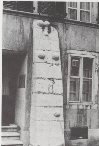
Contrefort d'une maison de la vieille ville de Bienne, avec 6 boules.
