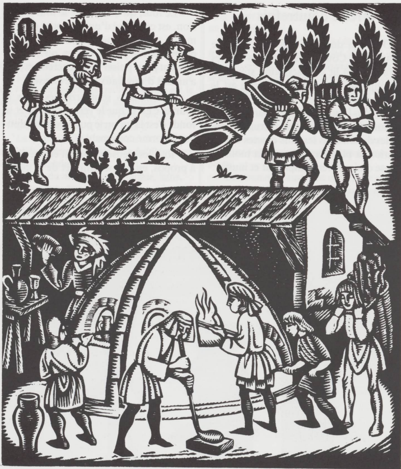
Verrerie au milieu du XIV e siècle qui représente une chaîne de travail depuis le remplissage des creusets jusqu'aux objets terminés en passant par la fusion et le soufflage.
