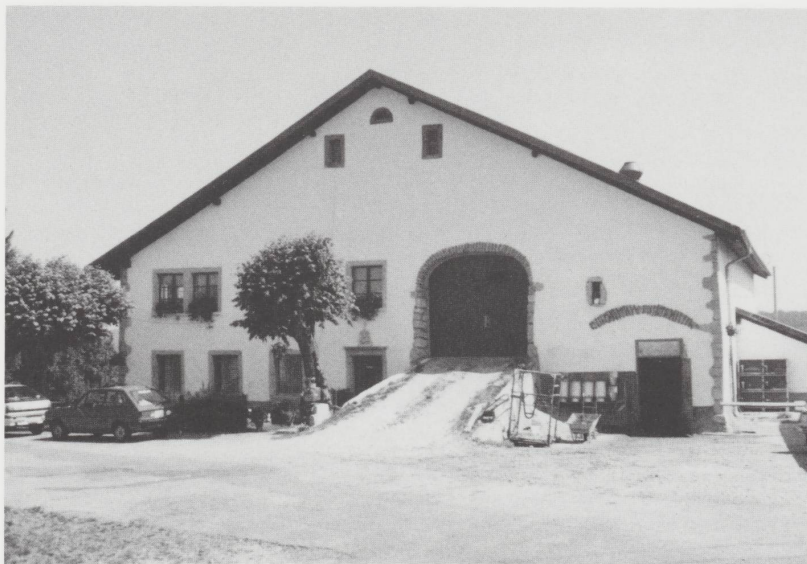
Montfaucon, Le Péchillard N° 44. La ferme dans son état actuel.
