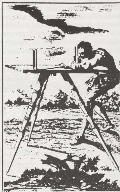
Fig. 5: Arpenteur procédant à un levé à la planchette.
