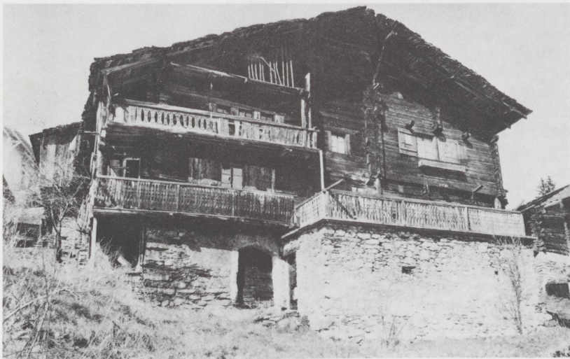
Galerie au-dessus du soubassement à Arbaz (Valais).
