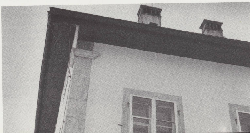
Sur-le-Crêt , XIX e siècle. Panneaux à losanges et étoiles lambrissant l'avant-toit. Photo 1978.
