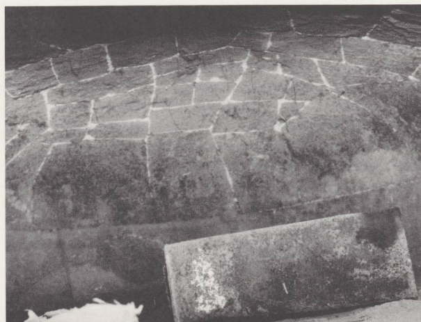
Le même four. On voit les voûtes aménagées pour conduire la fumée du four jusqu'à la cheminée. En-dessous de la gueule du four, le cendrier. Photo 1980.
