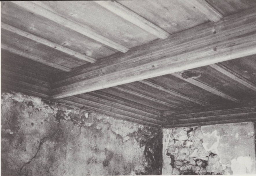
La Rangée-des-Robert, plafond du XVII e siècle, formé d'un cadre de solives et d'une solive médiane richement moulurés supportant de larges planches assemblées par liteaux rainés. Photo 1980.
