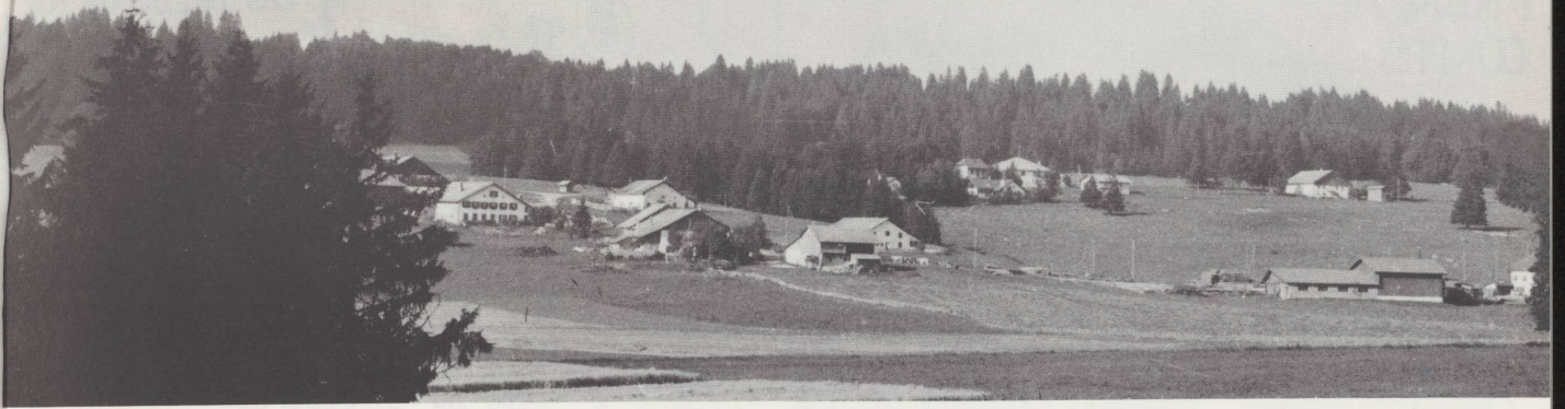
Un hameau franc-montagnard : Le Cerneux-Veuil-Dessous . Il se compose d'un groupe primitif se prolongeant vers l'est par une rangée . Le hameau est installé sur une pente douce et non au fond de la dépression. Vue du sud-ouest en 1988.
