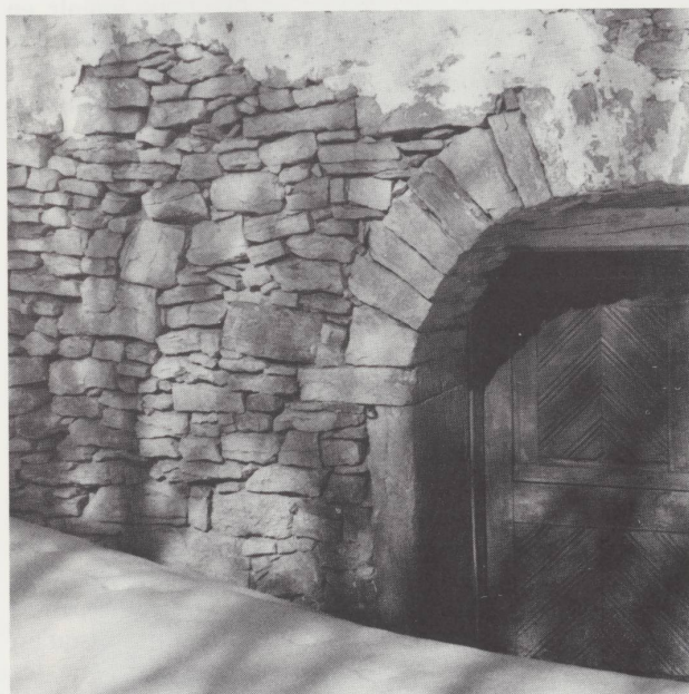
Maçonnerie au Peu-Claude (1749). Façade sud, détail, 1980.
