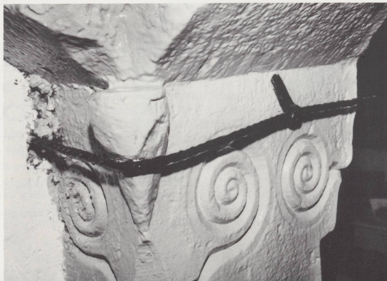
La Combe-du-Pélu , maison de 1635, chapiteau d'un pilier du tué en pierre, autrefois libre. Spirales imitées du style ionique (?), torsade en fer forgé pour accrocher des ustensiles, console pour lampe à huile. Le pilier est quadrangulaire largement chanfreiné. Photo 1978.
