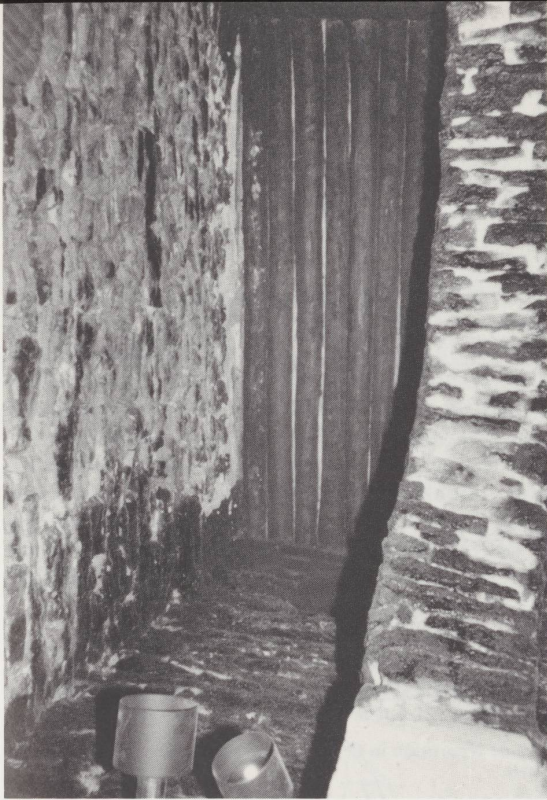
Même cuisine, les rondelats vus en contre-plongée.
