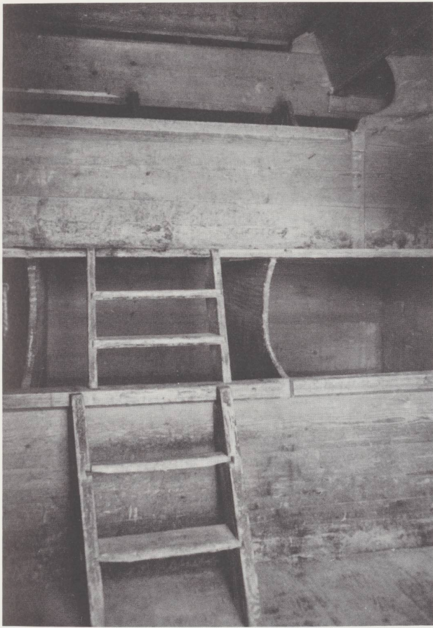
Le Creux-des-Biches , intérieur d'un grenier, 1689. Entchaîtres sur 3 étages, escabeaux pour accéder aux étages supérieurs. Photo en 1980.
