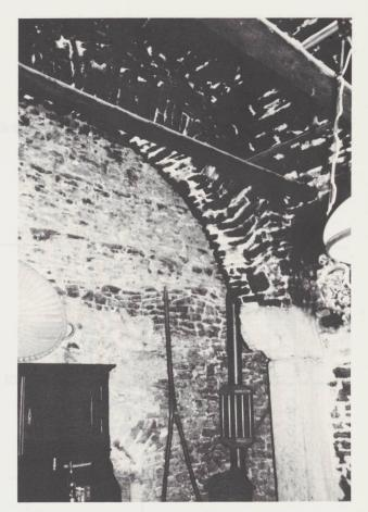
Une cuisine voûtée au *Peu-Péquignot* (1653). On voit ici l'arc doubleau pare-étincelles et l'étroite partie arrière couverte par les *rondelats*. L'arc repose sur un corbeau mouluré et un piédroit de pierre de taille. Perches pour fumer la viande. Photo 1980.
