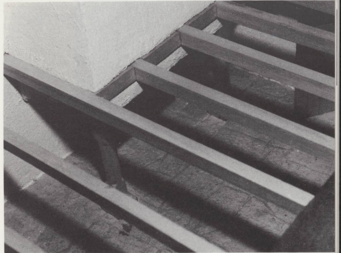
Maquette d'une maison de 1682 à La Combe-du-Pélu , réalisée par l'EPFL. Elle montre la structure du plafond de la cuisine s'appuyant sur la bande de la cheminée.
