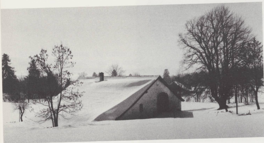
Le Haut-des-Vieilles, maison post-gothique. L'orientation assure un approvisionnement maximum de la citerne. Vue du nord-est en 1981.
