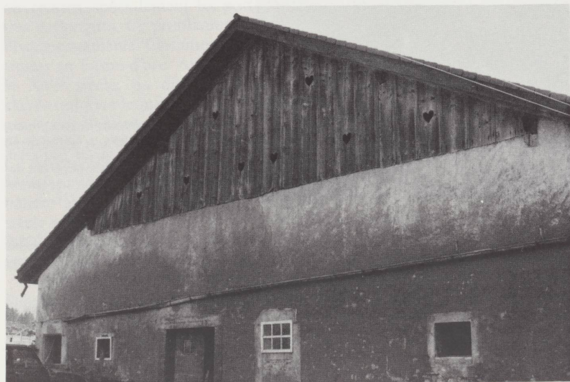
Ouvertures d'aération du pignon nord en forme de coeur, le Cerneux-Veusil, 1702 , vue du nord-ouest en 1988.
