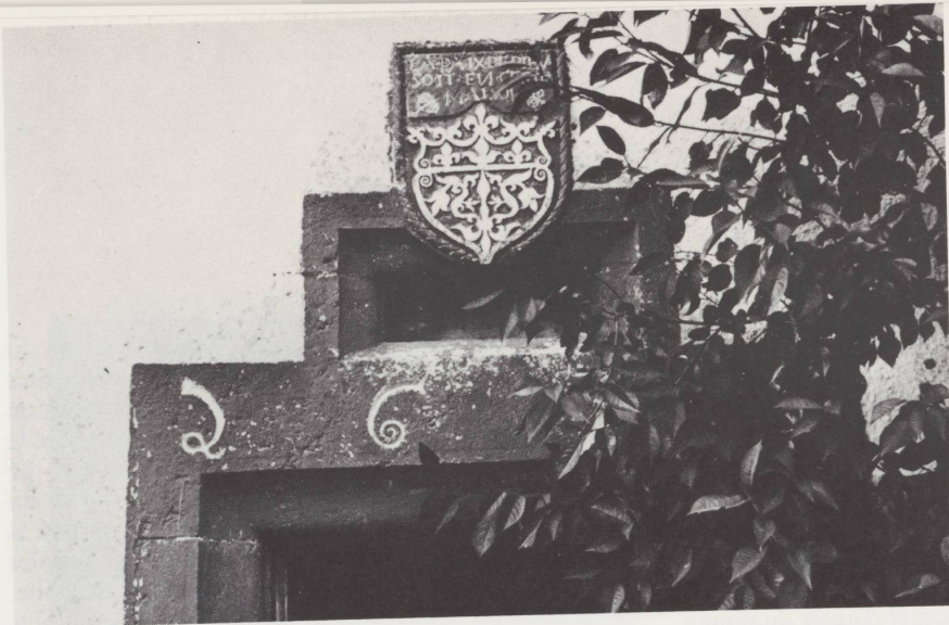
La Combe-de-Pélu. Porte d'entrée post-gothique avec fenêtre barlongue et écu ornemental. L'inscription entaillée : LA. PAIX. DE. DIEV./SOIT.EN.CESTE/MAISON 16 (35). Moulure : doucine. Notez la polychromie. Façade sud, détail, 1945.
