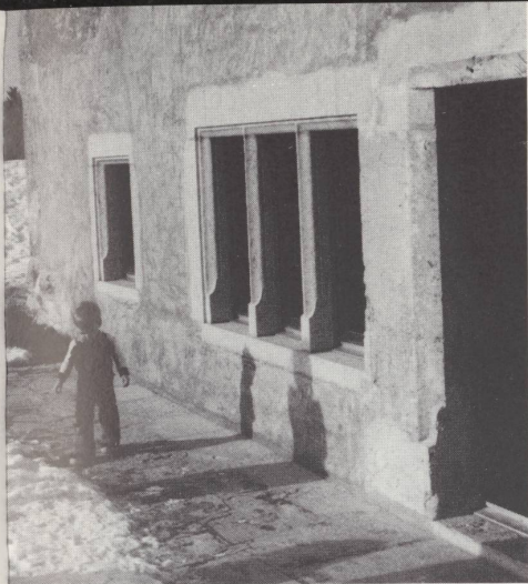
La Rangée-des-Robert. Meneaux restitués dans fenêtre reconstituée en façade ouest. Vue du sud-ouest, détail, 1980.
