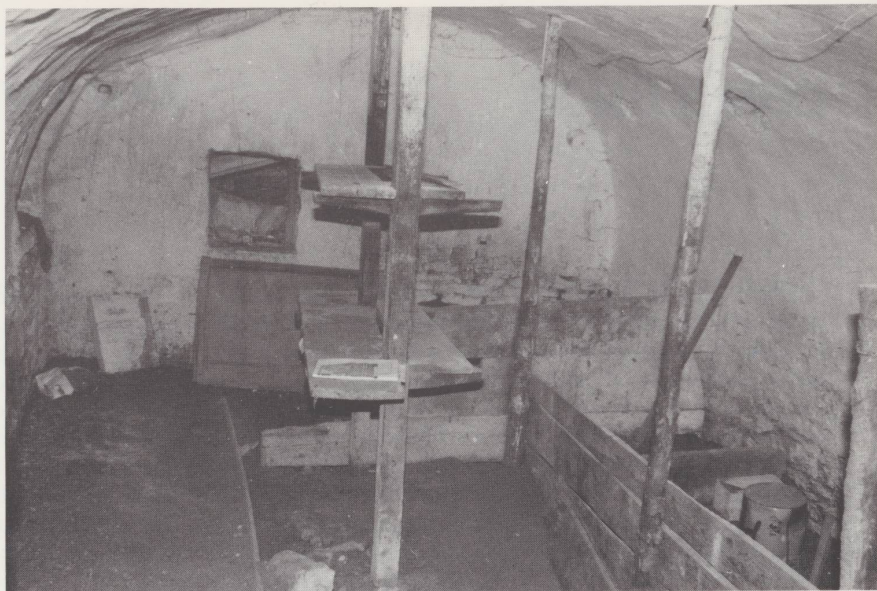
Autre étagère dans une cave voûtée au Peuchapatte. Niche dans la lunette et soupirail dans le piédroit de gauche. Photo 1980.
