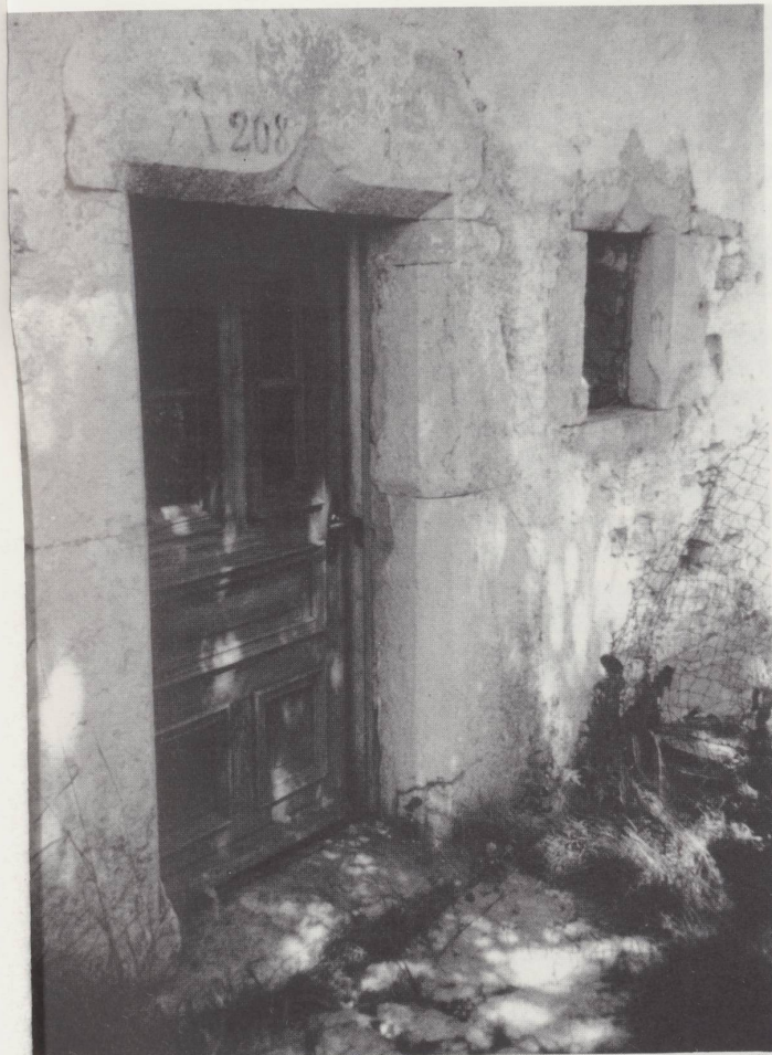
Porte et fenêtre du XVI e siècle au Peuchapatte , toutes deux ornées d'un arc infléchi surbaissé. Façade sud, détail, 1980.
