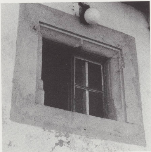
La Chaux-d'Abel . Fenêtre de grange haute, XVII e siècle, barlongue, avec retour de moulure au milieu du linteau. Moulure : doucine. Façade sud, détail, 1978.
