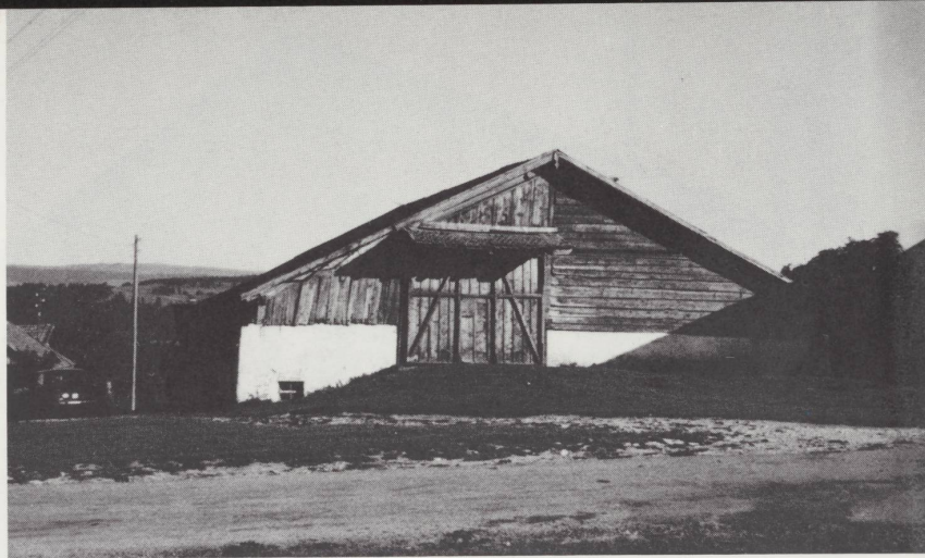
Le Peuchapatte, maison du XVII e siècle. Vue d'un pignon rural avec entrée de grange ; le mur est ici extrêmement bas. Vue du nord en 1976.
