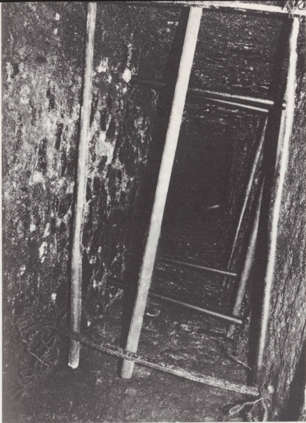
Le Peu-Claude, hotte vue en contre-plongée, avec les perches pour suspendre la viande à fumer. Etat en 1980.
