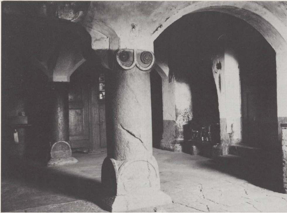
La Grande Coronelle (1621), cuisine. 2 piliers libres à socles cubiques et chapiteaux à spirales portent les arcs encadrant le tué . Vue de l'ouest en 1929.
