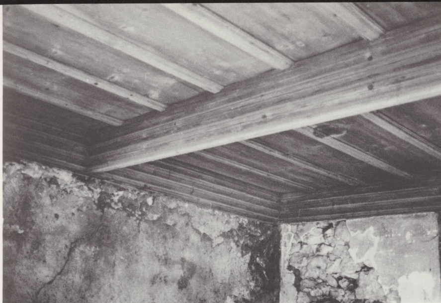
La Rangée-des-Robert, plafond du XVII e siècle, formé d'un cadre de solives et d'une solive médiane richement moulurée supportant de larges planches assemblées par liteaux rainés. Photo 1980.
