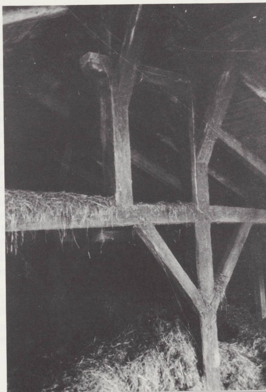
Charpente au Peuchapatte . On a évité ici de disposer une rangée de colonnes juste à l'endroit du faîte, raison du porte-à-faux au-dessous du poinçon gauche, qui correspond au faîte. Ce dispositif reste lui aussi rare. Photo 1980.
