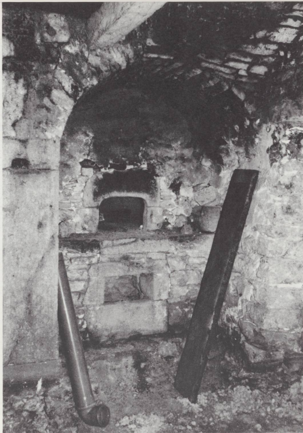
Intérieur d'un four à pain à La Rangée-des-Robert . Chaque pierre réfractaire est taillée « sur mesure ». Photo 1980.
