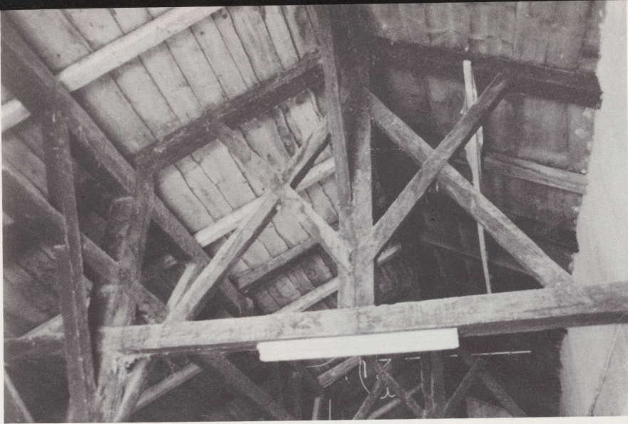
Charpente franc-montagnarde de 1840, Le Cerneux-Lombard . Poutres noires de fumée, voligeage refait ainsi que la plupart des chevrons. On a ici, exceptionnellement, des croix de St-André transversales ainsi qu'une sous-panne intermédiaire (à gauche), ce qui n'est absolument pas habituel mais permet d'écarter davantage les fermes. Photo 1980.
