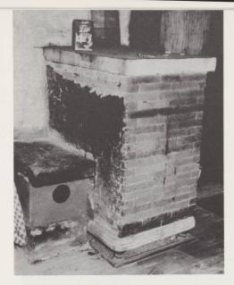
La Chaux-d'Abel, fourneau à banc en briques. Pieds tournés, socle mouluré en pierre, dalle de couverture probablement refaite. Photo 1978.
