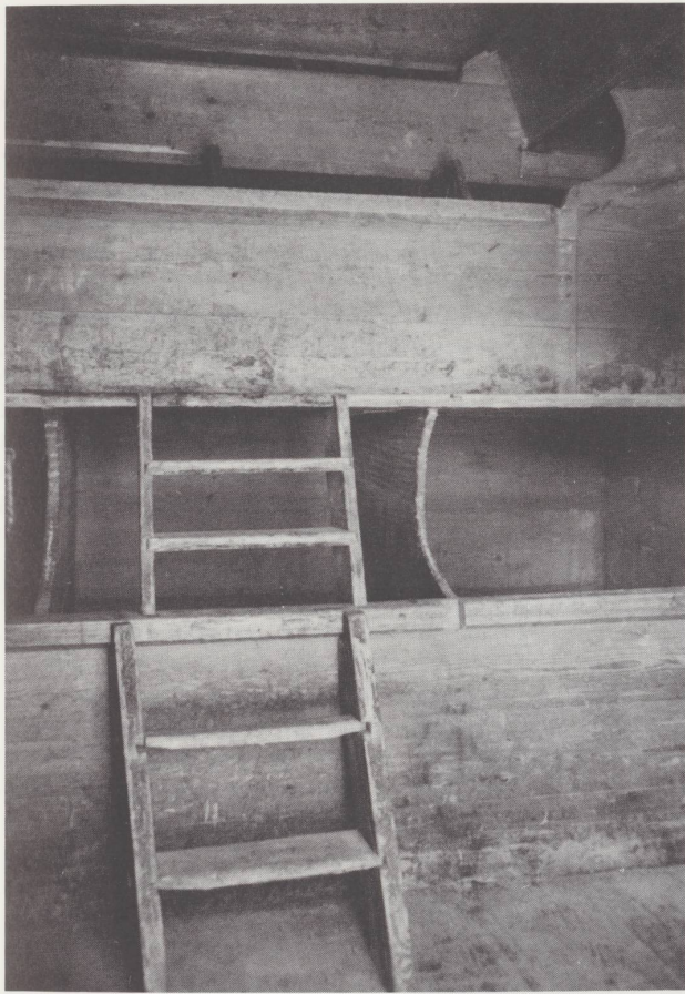
Le Creux-des-Biches , intérieur d'un grenier, 1689. Entchaîtres sur 3 étages, escabeaux pour accéder aux étages supérieurs. Photo en 1980.
