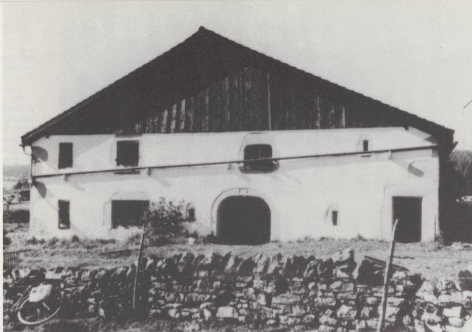
Façade post-gothique à La Chaux-d'Abel (1663) illustrant la remise en valeur néo-rustique. Le crépi zigzague autour des ouvertures. Vue du sud en 1978.
