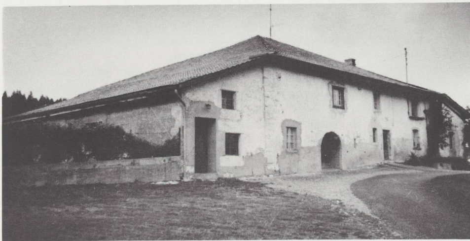
Au Cerneux-Veusil-Dessous , maison du XVI e siècle: l'unique toiture à 4 pans subsistant dans la zone d'inventaire. Agrandissement à l'est et à l'ouest, toutes les ouvertures modifiées sauf le portail du devant-huis . Vue du sud-ouest en 1979.
