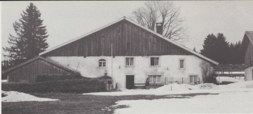
La Ferme de l'Hôpital à La Chaux-d'Abel. Certaines maisons soignées ont pourtant un pignon lambrissé. Dépouillé de ses meneaux en 1797, la fenêtre barlongue (à droite) s'est cassée et a été refaite en 1825. Vue du sud en 1978.
