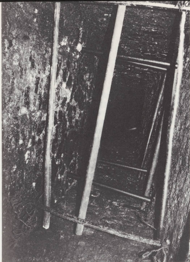
Le Peu-Claude, hotte vue en contre-plongée, avec les perches pour suspendre la viande à fumer. Etat en 1980.
