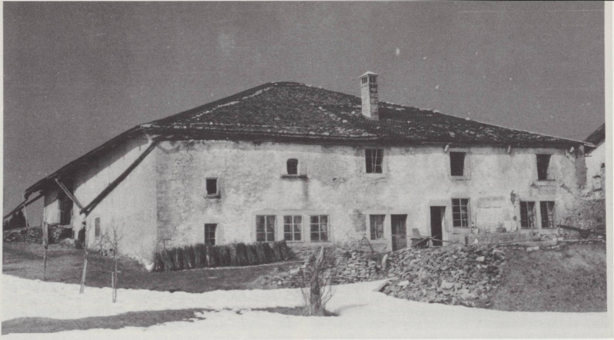
Ce document exceptionnel montre la grande métairie du Cerneux-Joly , construite en 1565. Le bâtiment est aujourd'hui méconnaissable. Sur cette photo d'archives, où l'on peut voir encore le toit partiellement en bardeaux, seules 2 ouvertures sont d'origine : une petite fenêtre au premier étage et la fenêtre de grange en anse de panier. Toutes les autres portes et fenêtres sont du XIX e siècle, ainsi que la cheminée. Vue du sud-ouest en 1940.
