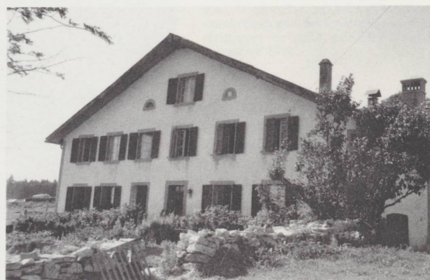
Façade entièrement refaite au XIX e siècle d'une maison du XVII e , au Cerneux-Veuil. Le goût post-classique subsiste jusqu'au XX e siècle. Vue du sud-est en 1980.
