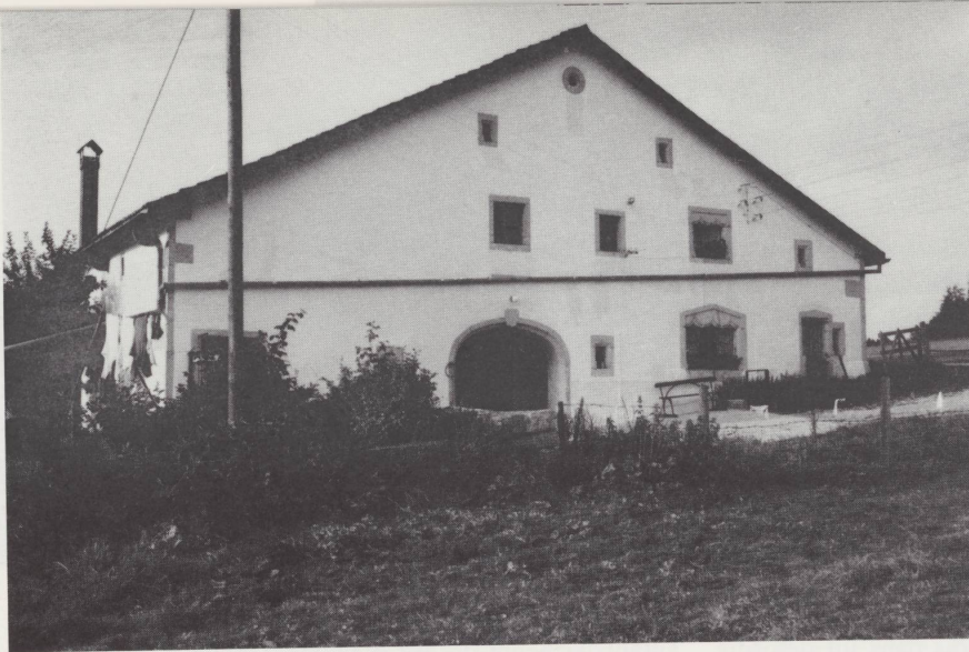
Cette façade post-gothique relativement peu modifiée à La Rangée-des-Robert présente encore son chéneau traversant la façade. Maison de 1621. L'asymétrie est ici bien visible. Vue du sud-ouest en 1978.
