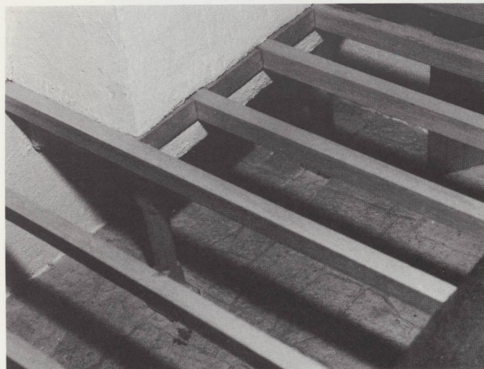
Maquette d'une maison de 1682 à La Combe-du-Pélu , réalisée par l'EPFL. Elle montre la structure du plafond de la cuisine s'appuyant sur la bande de la cheminée.
