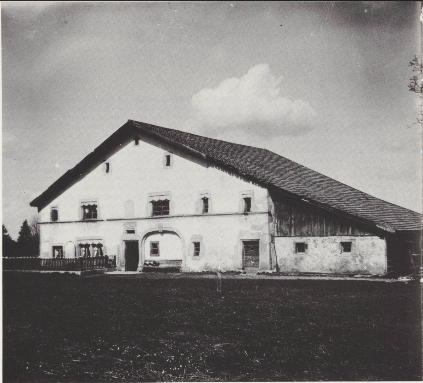
La Grande Coronelle à La Chaux-d'Abel, façade sud. Ce bâtiment de 1621 est déjà ici affecté de nombreuses transformations : portail du devant-huis obturé en 1797, fenêtre du cabinet agrandie au XIX e siècle, meneaux ôtés, avant-toit rallongé, annexe est. Pourtant – et même dans son état actuel – il reste un joyau de notre architecture. Vue du sud-est en 1929.
