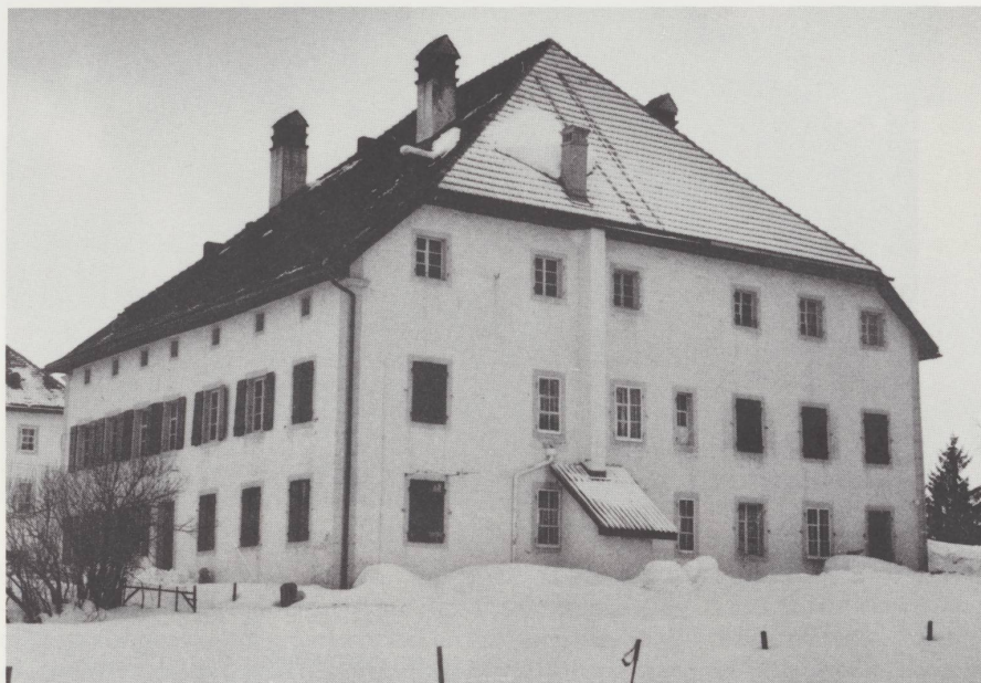
Maison maltournée de 1867 à La Chaux-d'Abel , agrandie peu après vers l'ouest et le nord. Deux niveaux et demi sous la gouttière, grandes dimensions, nombreuses grandes fenêtres sont caractéristiques de cette période. Vue du sud-est en 1978.
