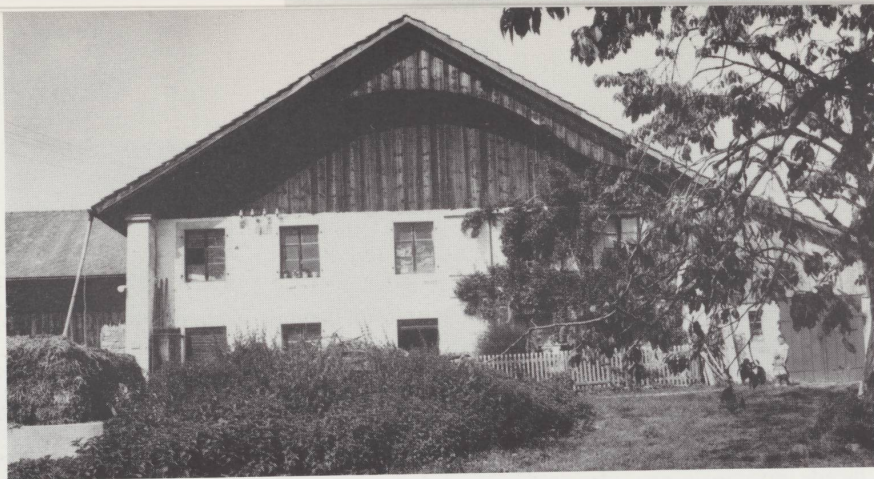
Maison post-classique au Droit-de-Renan . Murs latéraux saillants et avant-toit lambrissé en berceaux à doucine brisée. Vue du sud en 1978.
