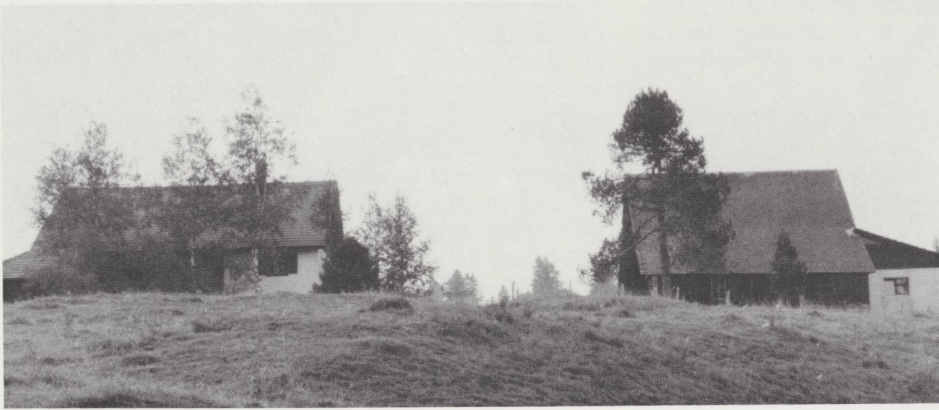
Au-dessus du gouffre de La Chaux-d'Abel subsiste l'habitation et un bâtiment industriel d'une ancienne tuilerie. Vue du sud en 1988.
