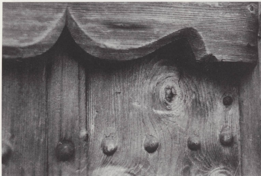
Le Cerneux-Lombard, détail d'une porte de grenier. Accolade chanfreinée ainsi que les montants. Chevilles exceptionnellement tournées. Photo 1980.
