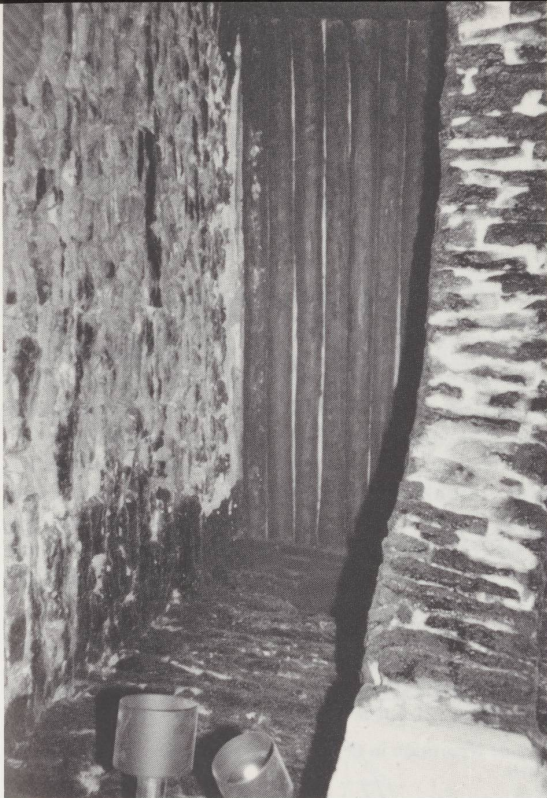
Même cuisine, les rondelats vus en contre-plongée.
