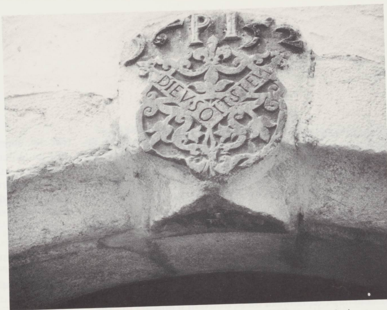
Ferme de l'Hôpital à La Chaux-d'Abel . Clé d'arc du portail de devant-huis sculptée sur ses 2 faces. La pointe de l'écu interrompt la moulure en doucine. Motif champlevé : 1652 P I (Pierre Jaquet); motif entaillé : DIEV. SOIT.SIEN (ici dedans). Inscription polychrome. Façade sud, détail, 1983.
