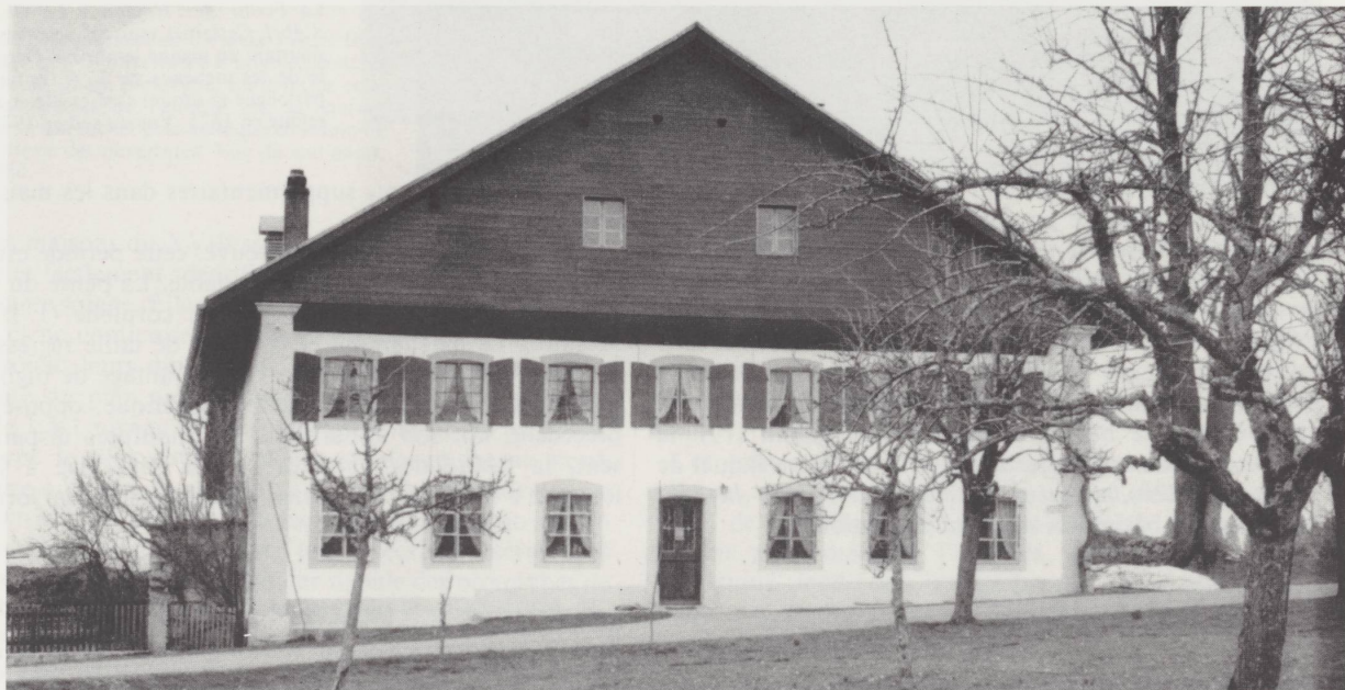
Façade post-classique à La Chaux-d'Abel , maison du XVIII e siècle. Murs latéraux saillants, pignon lambrissé à neuf en 1976, en surplomb de la façade. Symétrie parfaite, rural rejeté à l'arrière du bâtiment. Vue du sud en 1978.
