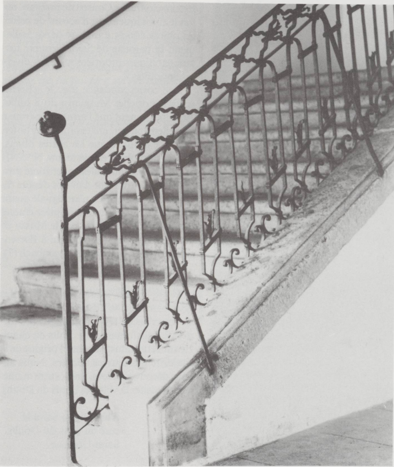
Balustrade de l'escalier de l'Hôtel de Ville.
