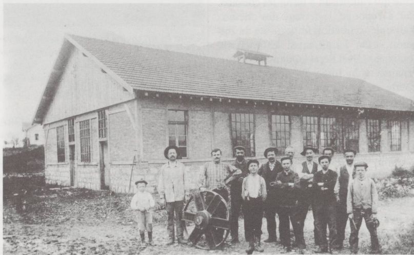
Ancienne fonderie à Courgenay démolie entre les deux guerres.
