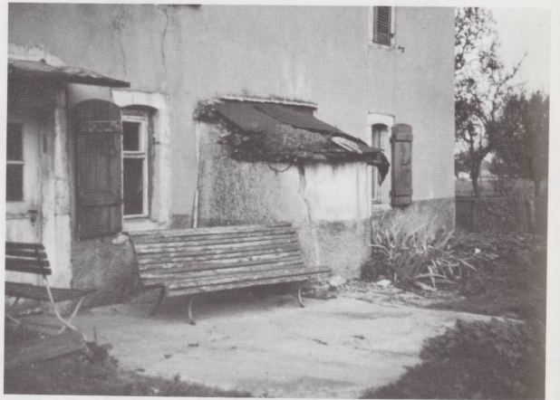
Four extérieur avec plant de joubarbe. On devine encore l'ancienne toiture en tuiles.
