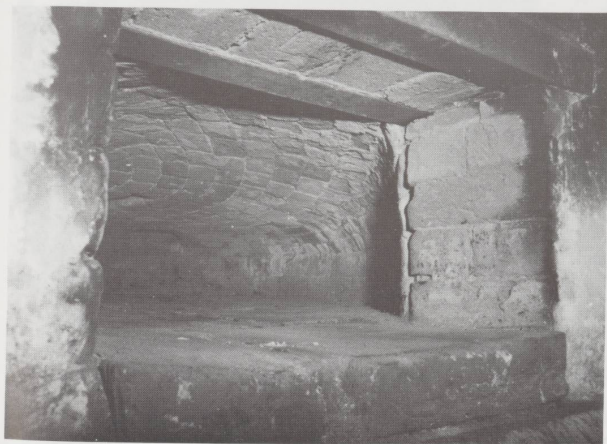
Gueule du four et voûte en briques réfractaires, aplatie.
