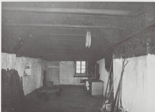
Vue de la cuisine prise sous les « rondelats ». Le départ de la voûte toute noire est derrière les outils, à droite. Les perches traversent la voûte. Elles soutiennent les bâtons auxquels on accroche la viande.
