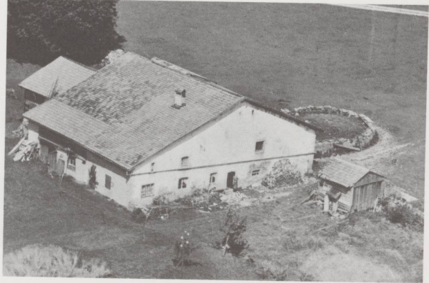
La Saigne-aux-Femmes, Le Noirmont. Construite en 1781, cette belle ferme devait être démolie. Elle a été sauvée par opposition de l'ASPRUJ. (Etat vers 1950.)
