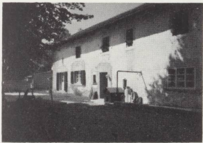
Une écurie aux Genevez transformée en logement.
