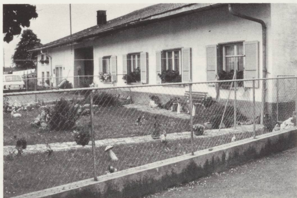
Transformation de façade aux Genevez. Les nouvelles fenêtres sont plus larges que hautes.
