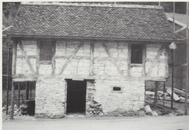
La toiture est refaite, les murs sont décrépis. Le 8 mai 1984. (Photo Jeanne Bueche)
