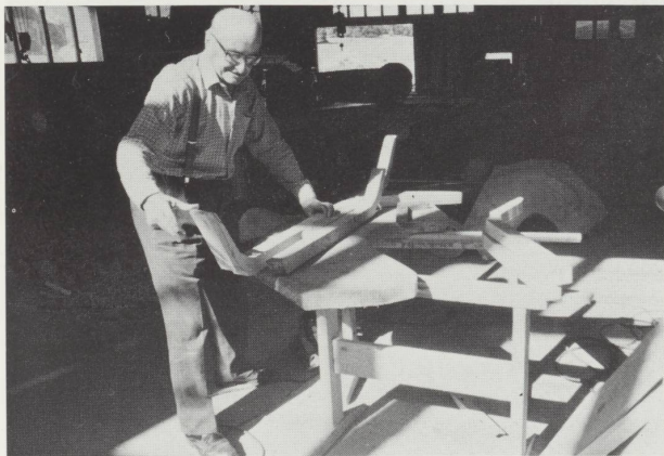
Manière d'ajuster les « courbes » qui se rejoignent par paire sur la ligne médiane. Par contre les « traversaux » sont d'une seule pièce et vont d'un bord à l'autre du plancher.
