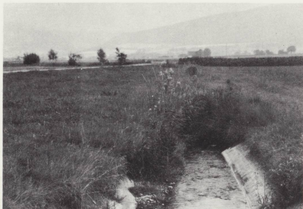
Le canal qui réceptionne les eaux de drainage a une pente de 7‰. Il traverse toute la plaine et va se jeter dans la Birse.
