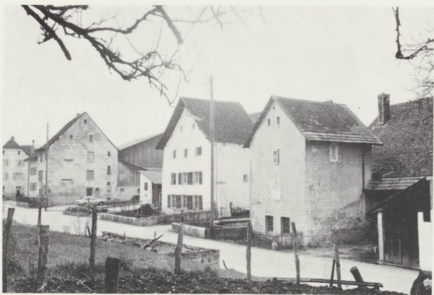
Le groupe formé par la maison-tour, cuisine et grangerie est ici complété par une petite porcherie fermant la cour du côté ouest. XVI e siècle, Chevez, N° 74, Bout-Dessus.
