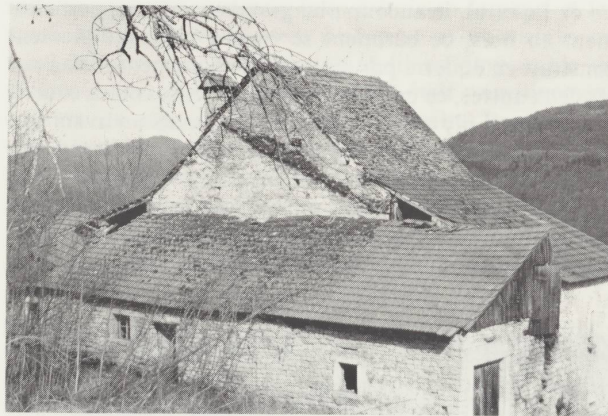
Le Sapois. Vue du côté N. L'écurie en appentis se trouve sur l'emplacement de l'ancienne cuisine, dont l'arrachement du toit contre la maison-tour est encore visible.
