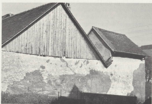
Rapport de volumes entre la grangerie et la maison-tour. N° 75, Chevez, Bout-Dessus.
