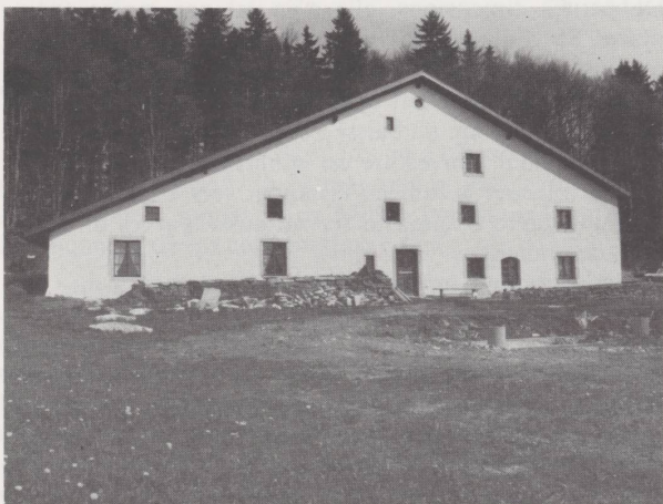
La façade sud après la rénovation. – (1981)
