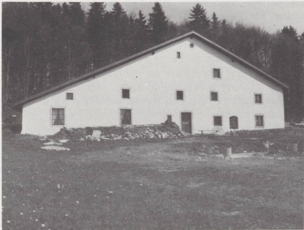
La façade sud après la rénovation. – (1981)
