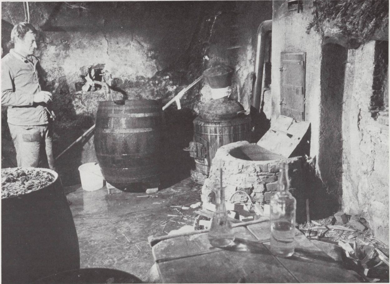
Local de distillation à Oisonfontaine. Dans l'angle, alambic à feu nu avec chaudière moderne et cucurbite ancienne d'où sortent les serpentins qui traversent le tonneau de refroidissement à eau ; la goutte tombe dans un seau en plastique ! Au premier plan : tonneau rempli de fruits fermentés. Derrière la table : ancien fourneau d'alambic maçonné sur lequel on plaçait la cucurbite. Tout à droite : bouche du four à pain.
