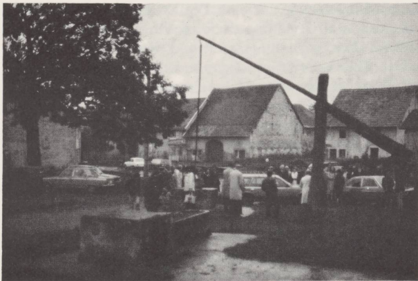
Au village de Croix, un puits à balancier.
