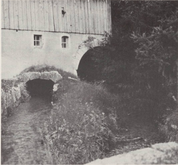
La sortie du canal sous la façade ouest du moulin.
