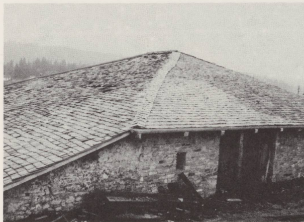
La rénovation du toit de badeaux a été terminée le 14 septembre 1979.
