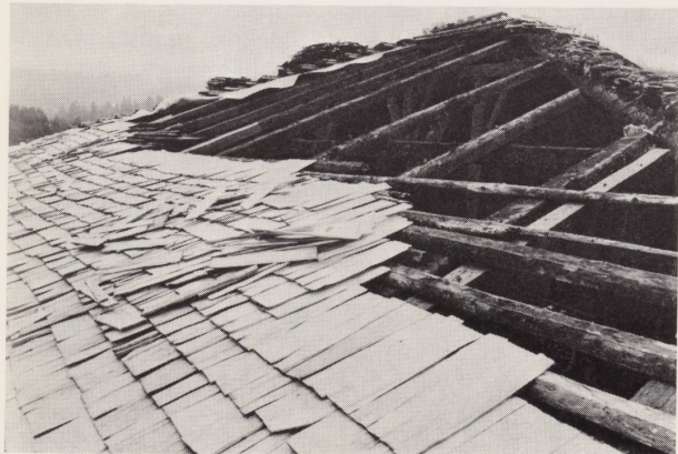
La pose des bardeaux sur le toit du Musée rural (photo Jean-René Mœschler).
