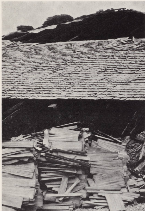
Bardeaux à poser et toiture en rénovation (photo Gilbert Lovis).
