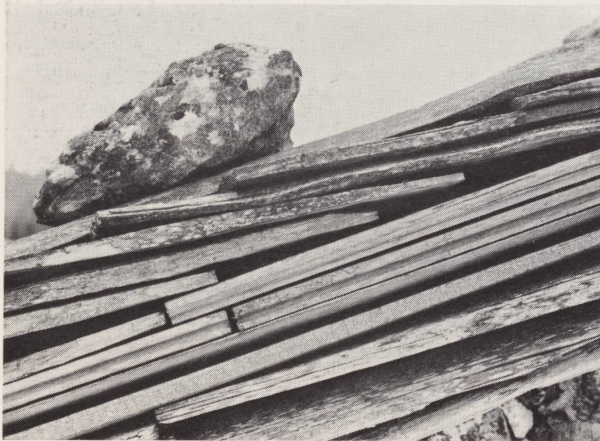
Le bord de l'ancien toit au même endroit (photo Gilbert Lovis).
