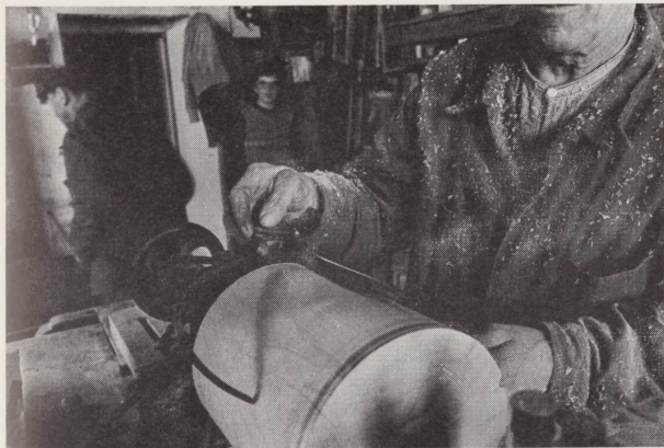
Calibrage du cylindre.
