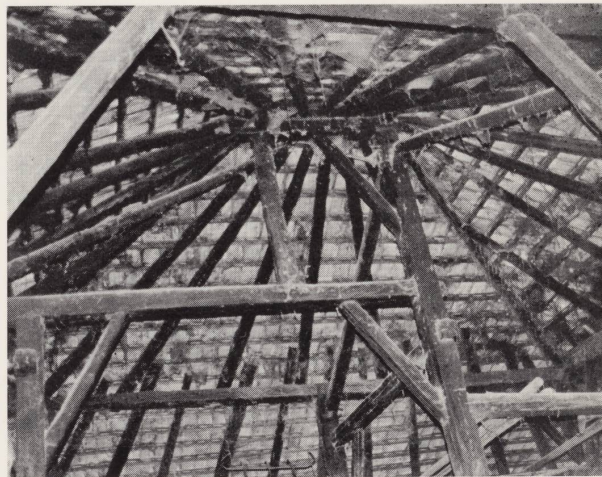
Semplain. La vieille maison. Charpente typique d'une ferme à quatre pans avec un court faite.
