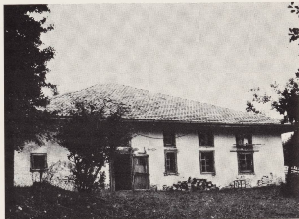
Semplain. Façade méridionale de la ferme à quatre pans.
