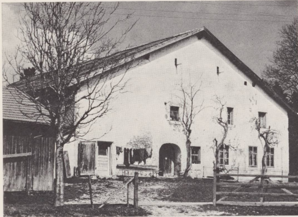
Façade méridionale (photo de Michel Villars).
