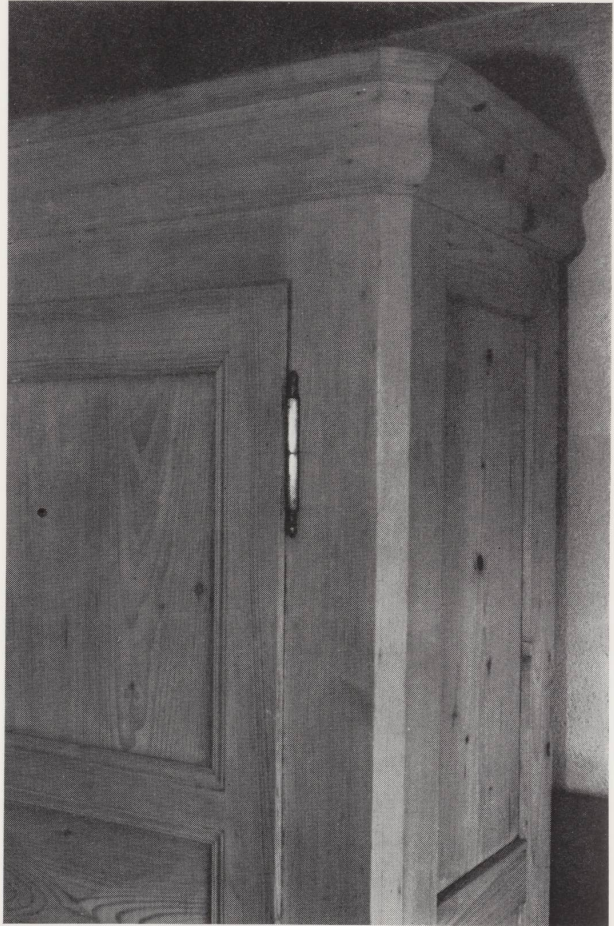
Disparition de la plate-bande et du chevillage ; les assemblages sont collés. (Marcel Frund, Courchapoix.)
