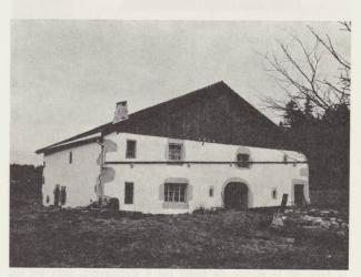
Daté de 1663, ce beau bâtiment est abîmé par les formes grossières de la taille laissée visible! Les deux meneaux de la fenêtre du poêle et celui de la fenêtre de l'étage manquent.
