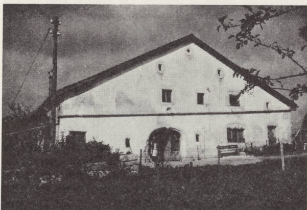
Peu d'avant-toit ; fenêtres petites à l'étage (une seule moderne). Les meneaux manquent à la fenêtre de droite et à celle du poêle au-dessous (linteau à arcs en accolades)
