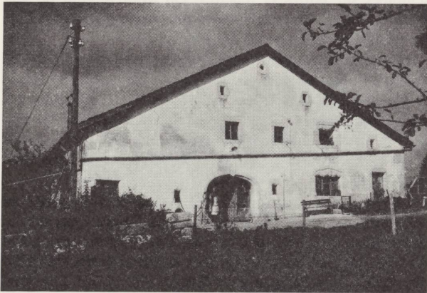
Peu d'avant-toit ; fenêtres petites à l'étage (une seule moderne). Les meneaux manquent à la fenêtre de droite et à celle du poêle au-dessous (lindeau à arcs en accolades)
