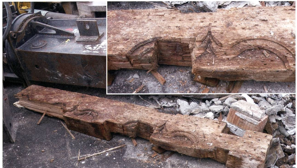
Abb. 15: Flüelen, Axenstrasse 2. Westfassade. Unterster Wandbalken der vorkragenden Fassade, dekoriert mit doppelt getreppten Kielbögen, die jeweils von einem Kreuz bekrönt werden. Einschnitt für die Eckverkämmung (rechts) (Foto während des Abbruchs: Ulrike Gollnick, BAB Gollnick).
