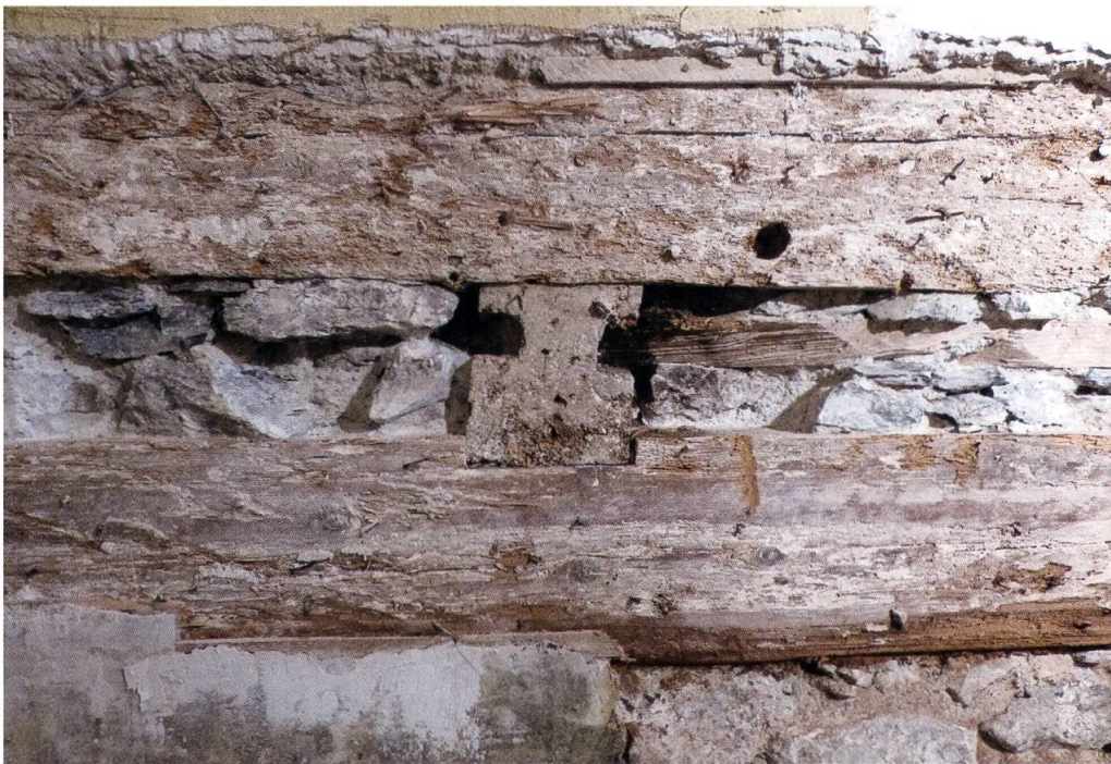
Abb. 10: Flüelen, Axenstrasse 2. Mittelgang. Blick gegen Westen. Sondierung 1. Durchstossende Balken der Bohlen-Balken-Decke des Sockelgeschosses. Die seitliche Nut dient zur Aufnahme der Bohlen (Foto: Georg Sidler, Schwyz).
