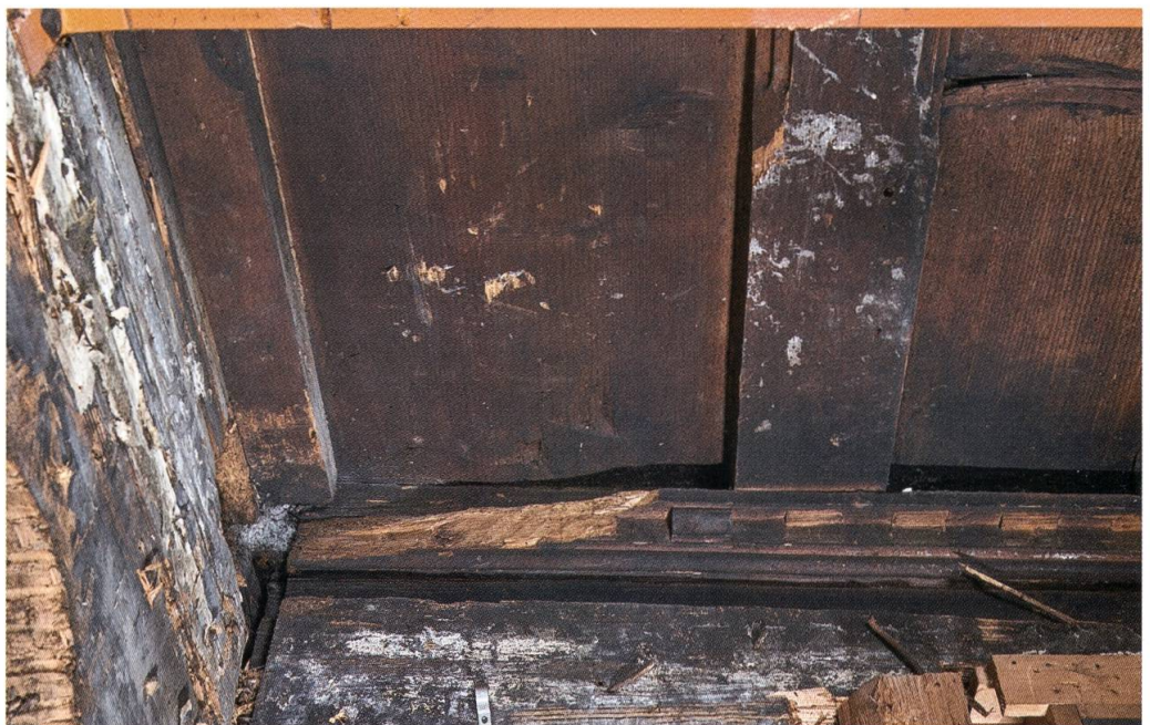
Abb. 8: Flüelen, Axenstrasse 2. Die Stube des ersten Wohngeschosses. Südwestecke, Blick nach oben. Die Bohlen-Balken-Decke liegt auf einem mit Konsolfries dekorierten Konsolbalken. Die Balken der Decke sind mit doppelt gekehlter Fasse und Ablauf profiliert (Foto: Georg Sidler, Schwyz).
