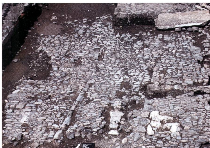
Abb. 15: Flüelen, Grabung Axenstrasse 2, Gasthaus «Weisses Kreuz» (2018). Ansicht der seeseitigen Pflasterung, die bauzeitlich zum Gasthaus gehört. Die markanten, aus grösseren Steinen gebildeten, parallel verlaufenden Linien weisen starke Abnutzung durch Wagenräder auf. Sie stammen wohl von einer immer wieder genutzten Fahrspur, um Menschen oder Waren vor dem Gasthaus ein- und auszuladen. Blickrichtung Norden (Foto: Marc Schnyder, ProSpect GmbH, Aarau).
